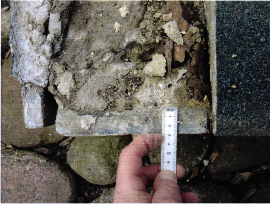
Foto. 5 Odkrywka po usunięciu płyty granitowej. Grubość pionowych płyt 3,0 cm.
