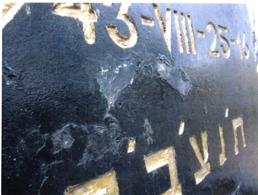
Foto. 10 Łuszcząca się powłoka malarska na pomniku.
