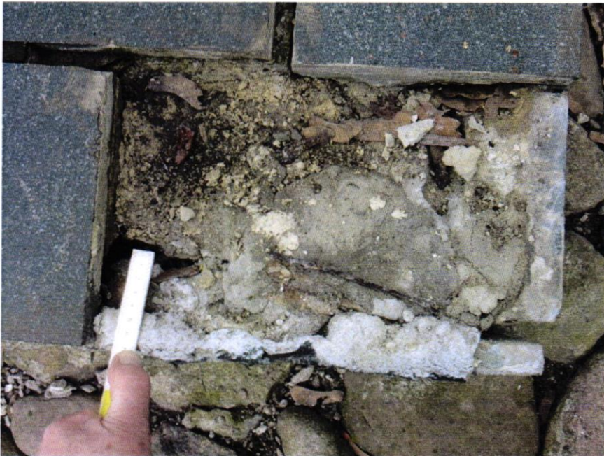
Foto. 4 Widok płyty betonowej po usunięciu poziomej płyty granitowej.
