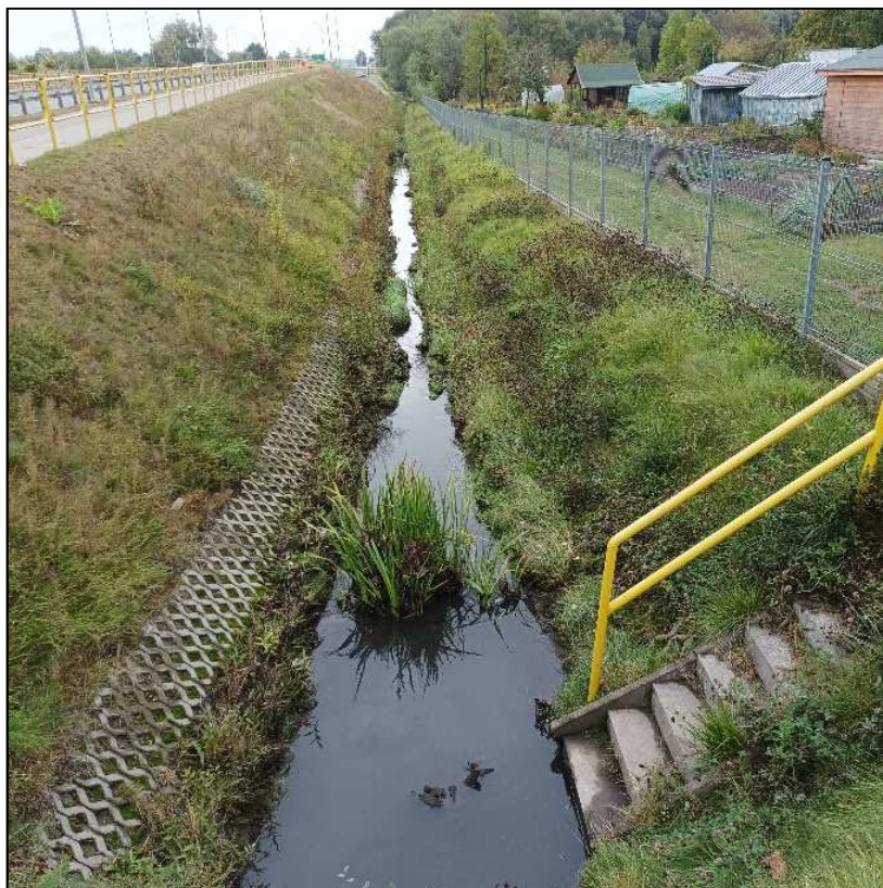
Zdjęcie 2 Rów otwarty pomiędzy ul. K. Ciołkowskiego a ROD im. Juliusza Słowackiego Fot. Elżbieta Drożdżal (19.09.2022 r.)
