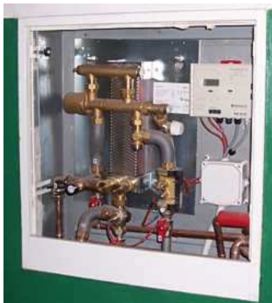
Rys. 15. Stacja mieszkaniowa c.w.u.
