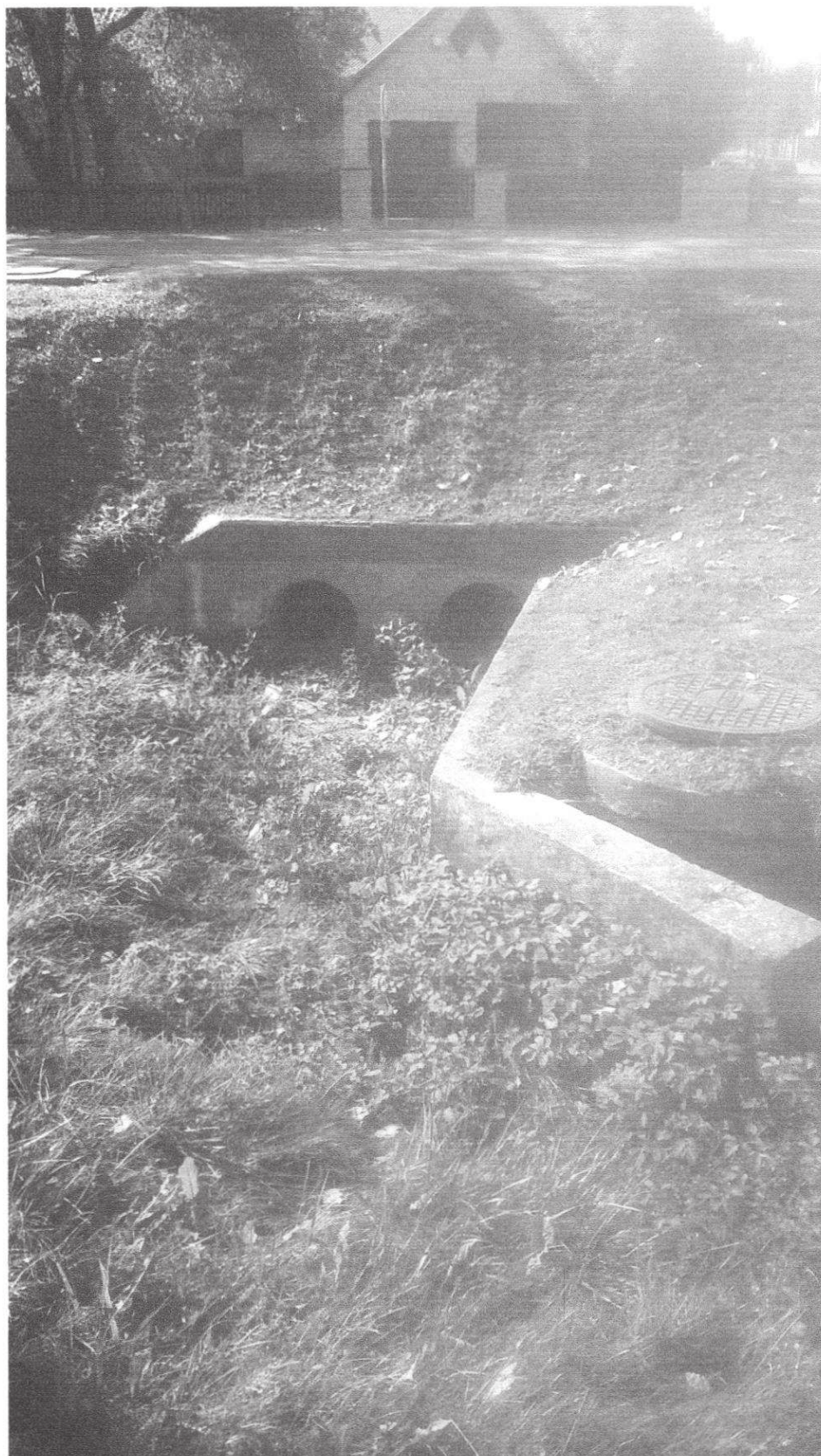
Fot. 8. Wylot przepustu na rowie odprowadzającym wodę do rzeki Białej dn. 2x50 cm w lewym wale (pod chodnikiem i ścieżką rowerową)
