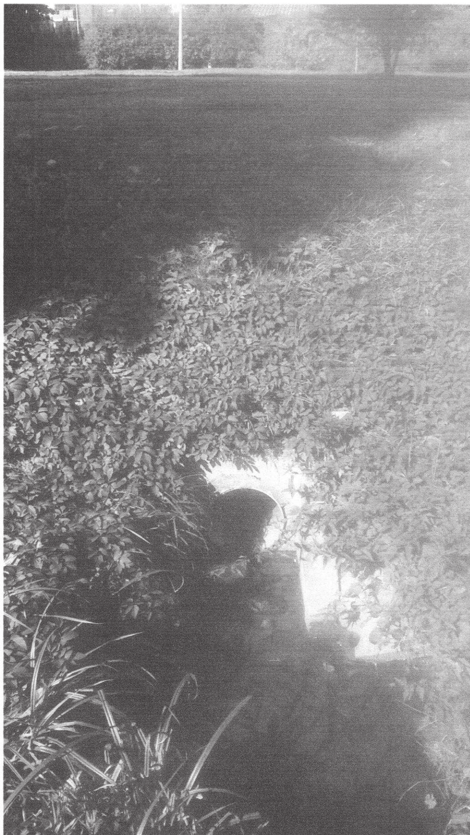
Fot.9. Przepust na rowie odpływowym odprowadzającym wodę do rzeki Białej Dn 50 cm
