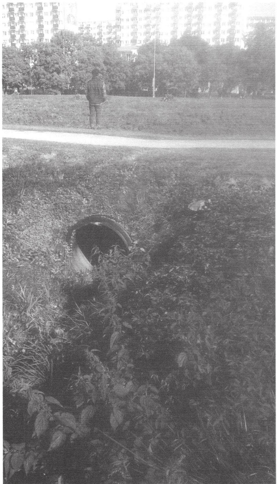
Fot.10. Przepust odprowadzający Wodę do rzeki Białej dn. 100 cm
