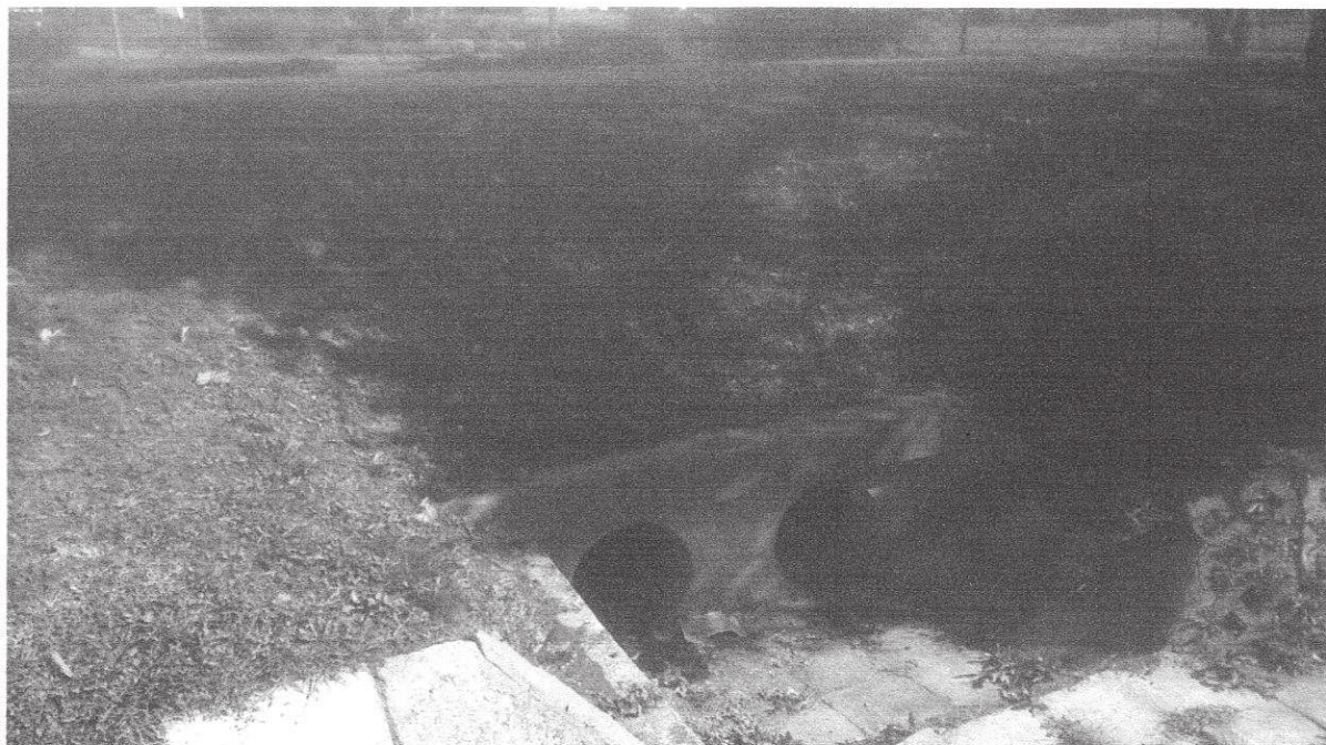
Fot. 7. Włot przepustu na rowie odprowadzającym wodę do rzeki Białej dn. 2x50 cm w lewym wale (pod chodnikiem i ścieżką rowerową)
