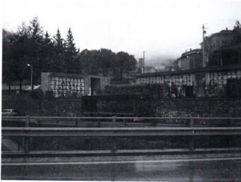
SEDRINA ( BG ) ITALIA cmentarz komunalny przed rozbudową
