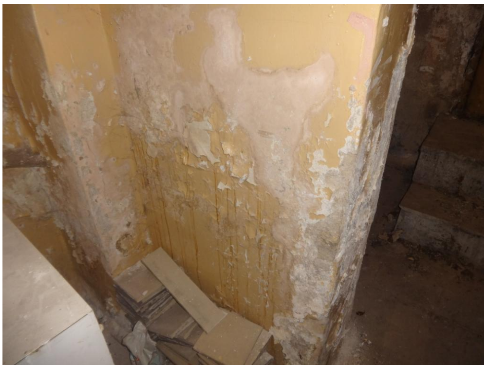
Fot.nr 29. widoczne zniszczenia spowodowane kapilarnym podciąganiem wilgoci
