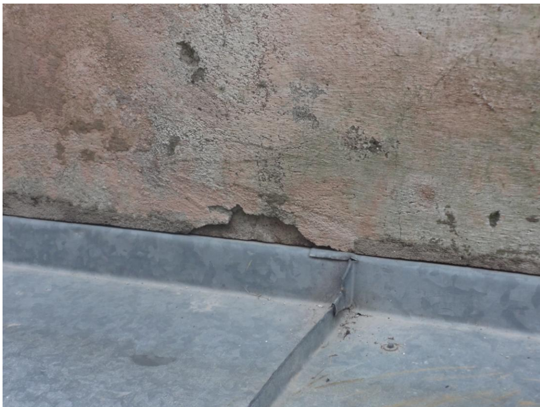
Fot.nr 26. zniszczone obróbki blacharskie powodują wnikanie wody w strukturę murów
