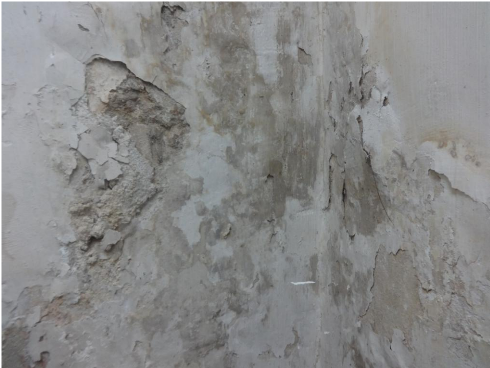
Fot.nr 41. widoczne zniszczenia spowodowane silnym zawilgoceniem murów
