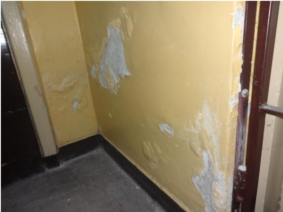
Fot.nr 33. zniszczone wyprawy tynkarskie spowodowane kapilarnym podciąganiem wody
