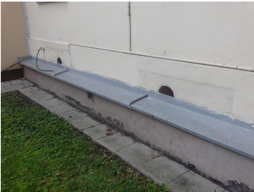
Fot.nr 21. niewłaściwie ukształtowana opaska wokół budynku powoduje dodatkowe zawilgocenie ścian
