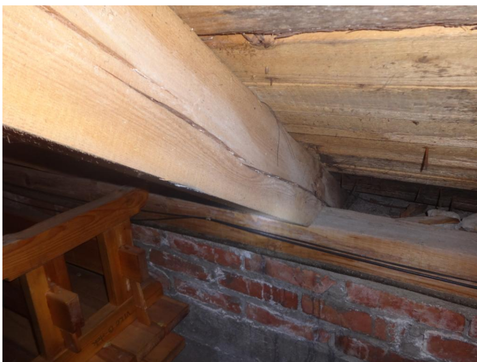
Fot.nr 39. widoczna konstrukcja wieźby dachowej wraz z deskowaniem. Widoczne spękania konstrukcji
