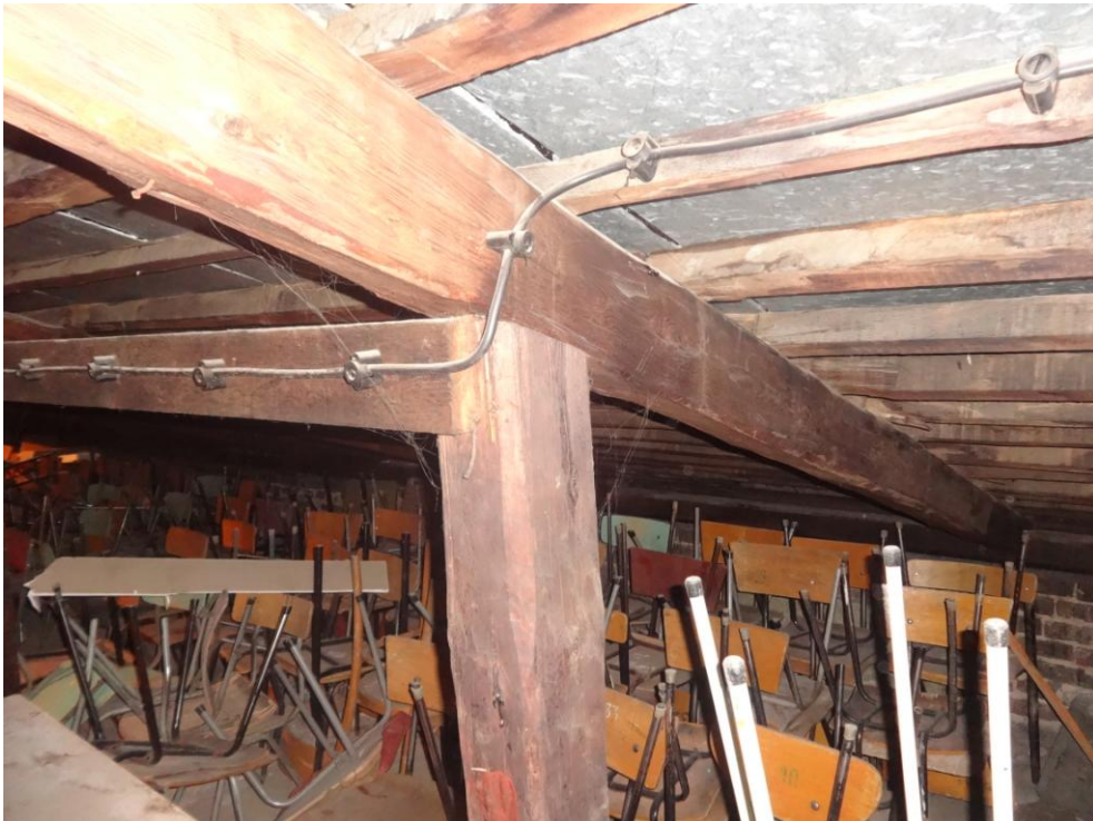
Fot.nr 52. widoczna konstrukcja wieżby dachowej wraz z pokryciem z blachy ocynkowanej
