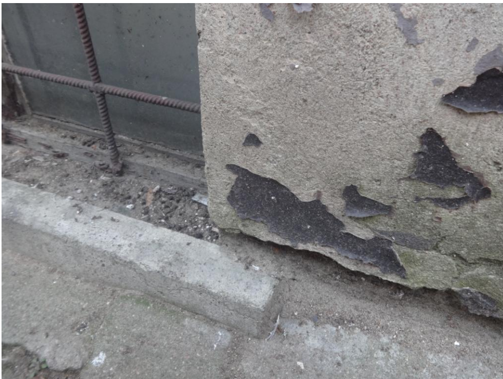
Fot.nr 6. widok zniszczonej elewacji spowodowany brakiem właściwej izolacji
