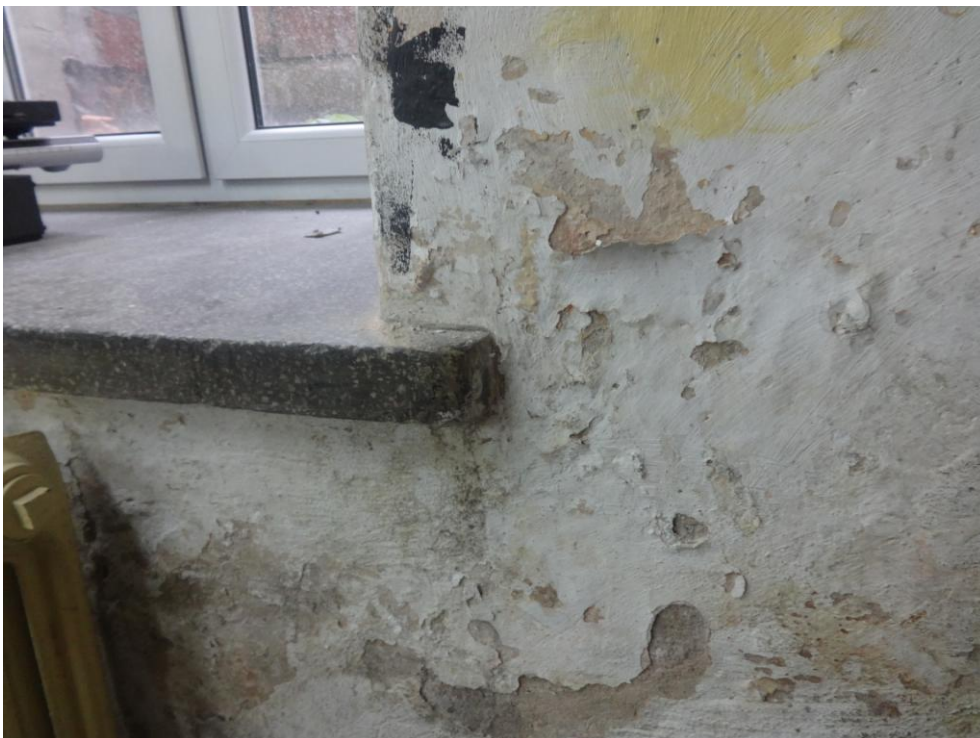
Fot.nr 36. widoczne zniszczenia spowodowane silnym zawilgoceniem murów
