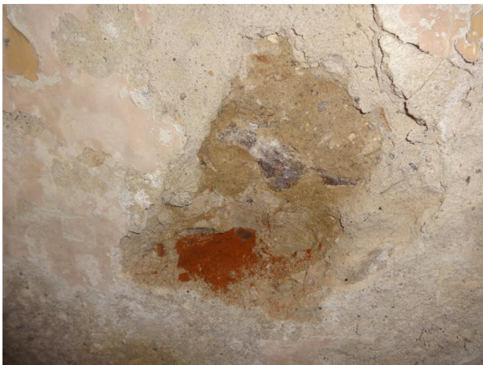
Fot.nr 33. widoczne odkrywki mające ustalić strukturę zawilgoconej ściany
