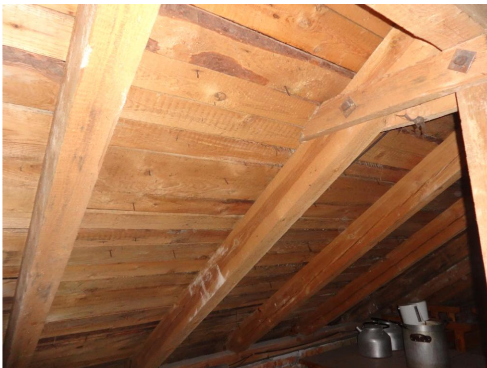
Fot.nr 37. widoczna konstrukcja wieżby dachowej wraz z deskowaniem. Widoczne spękania konstrukcji
