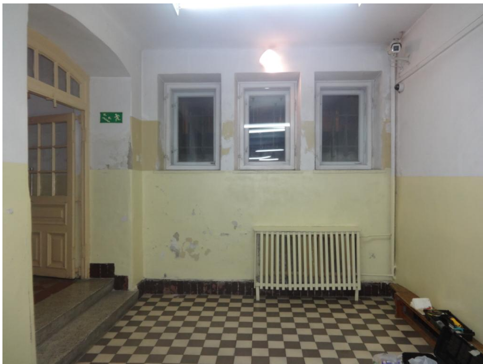
Fot.nr 49. zniszczenia ściany spowodowane brakiem izolacji przeciwwilgociowej
