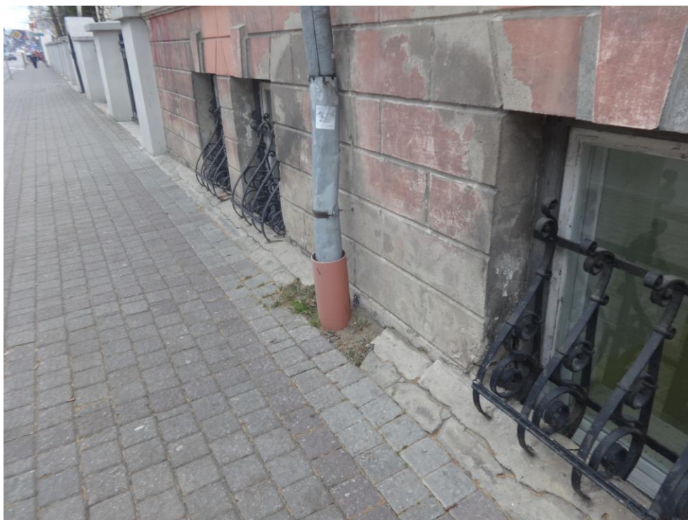
Fot.nr 11. zniszczona elewacja oraz substancja muru. Niewłaściwe ukształtowanie terenu wokół budynku powoduje dodatkowe zwilgocenie obiektu
