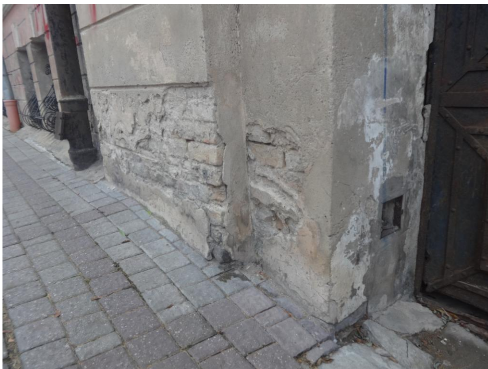
Fot.nr 8. zniszczona elewacja oraz substancja muru.
