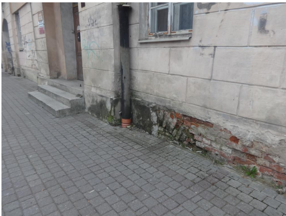
Fot.nr 5. zniszczona elewacja oraz substancja muru. Niewłaściwe ukształtowanie terenu wokół budynku powoduje dodatkowe zwilgocenie obiektu
