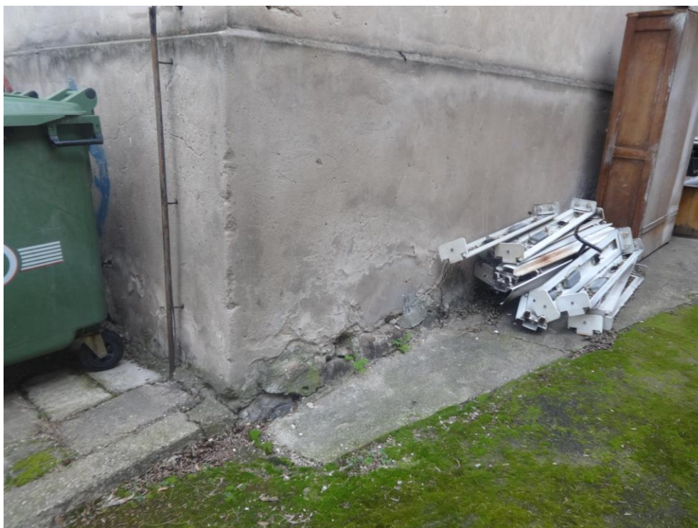
Fot.nr 14. zniszczona elewacja oraz substancja muru. Niewłaściwe ukształtowanie terenu wokół budynku powoduje dodatkowe zwilgocenie obiektu
