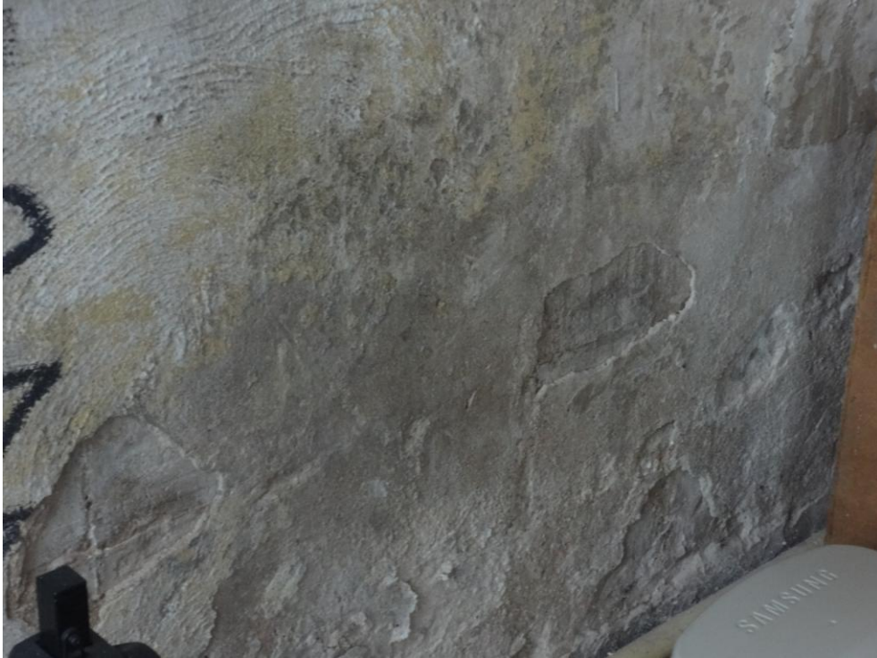
Fot.nr 37. widoczne zniszczenia spowodowane silnym zawilgoceniem murów
