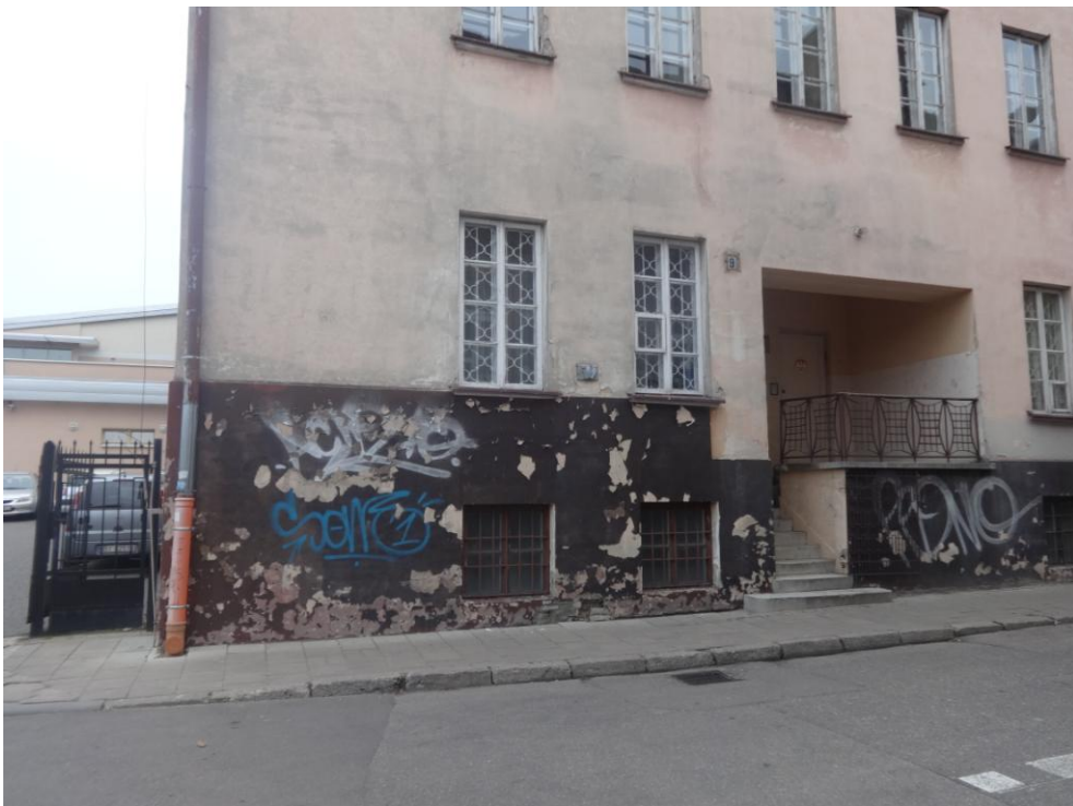
Fot.nr 11. zniszczona elewacja budynku spowodowana silnym zawilgoceniem murów
