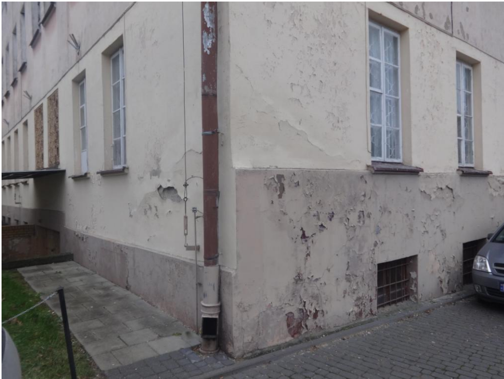
Fot.nr 16. zniszczona elewacja. Niewłaściwe ukształtowanie terenu wokół budynku powoduje dodatkowe zwilgocenie obiektu
