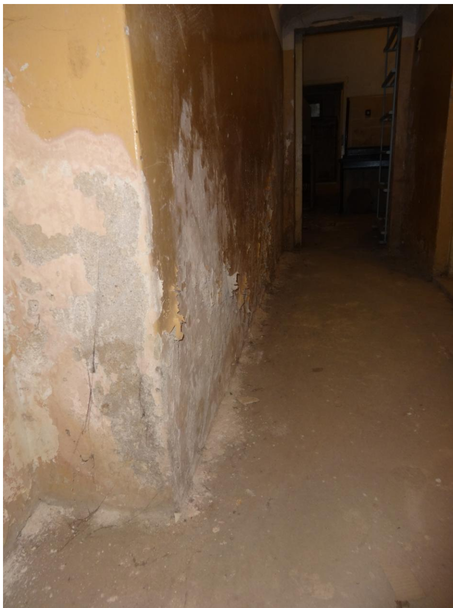
Fot.nr 28. brak właściwej izolacji prowadzi do zniszczenia struktury zawilgoconej ściany
