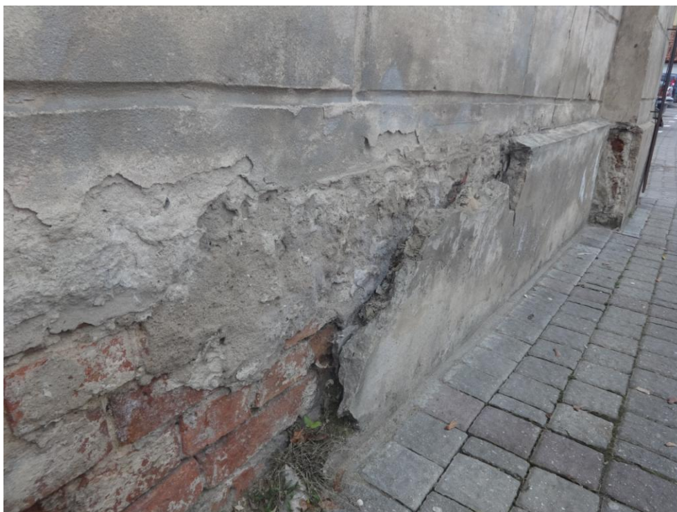
Fot.nr 6. zniszczona elewacja oraz substancja muru. Silne zawilgocenie ścian powoduje odspajanie wypraw tynkarskich
