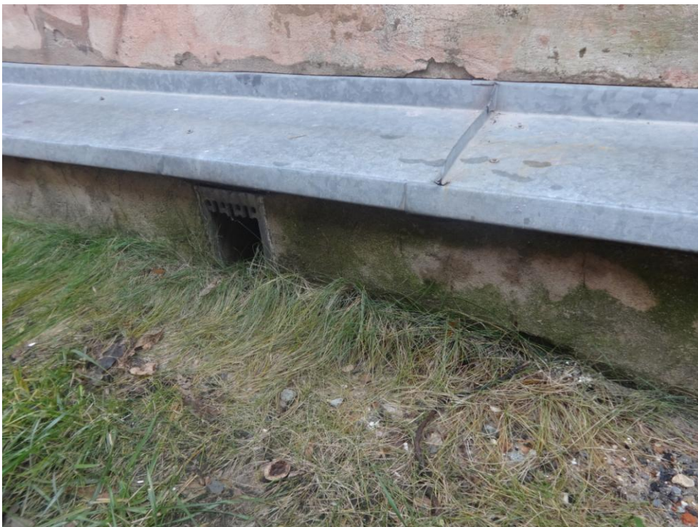
Fot.nr 25. brak właściwej opaski wokół budynku dodatkowo naraża ściany na długotrwałe działanie wilgoci
