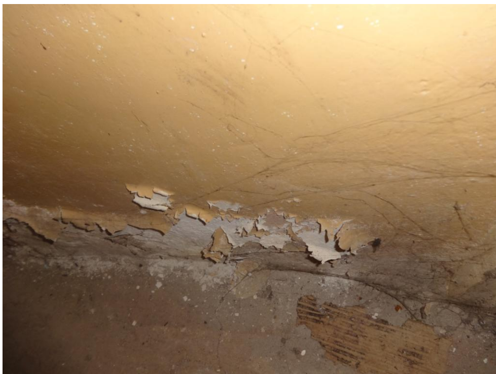
Fot.nr 25. zniszczona wyprawa malarska przez kapilarne podciąganie wilgoci
