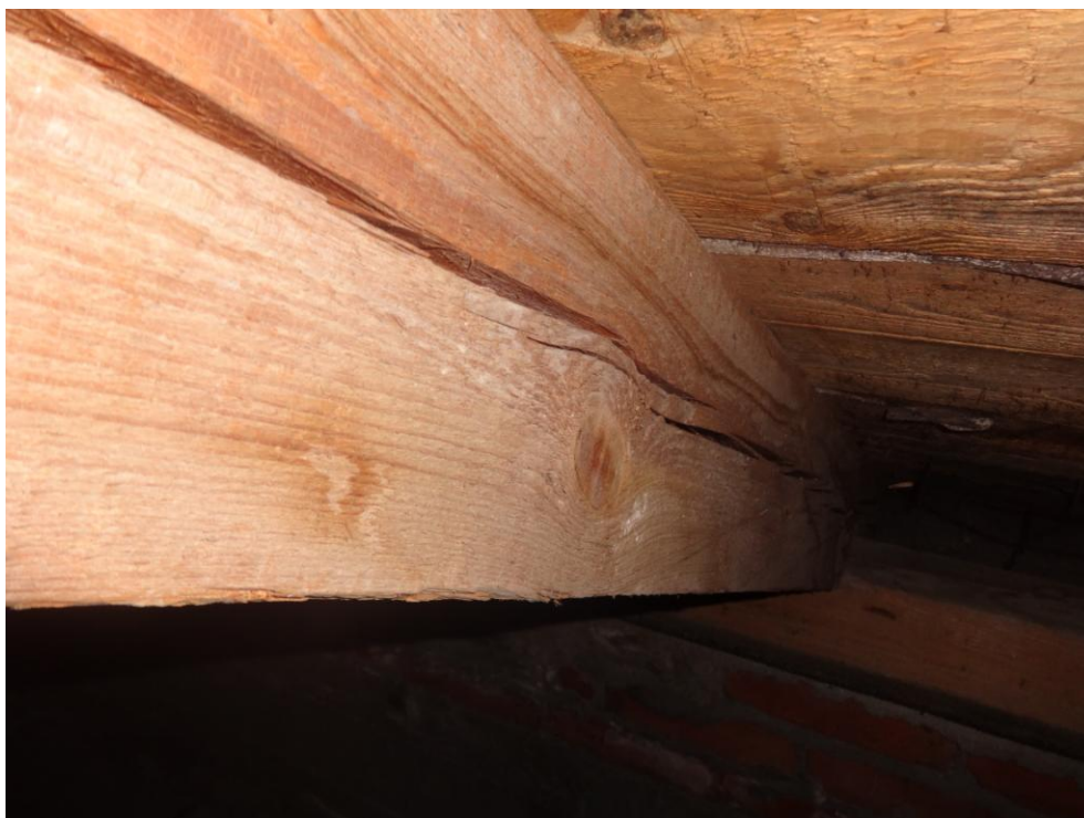
Fot.nr 40. widoczna konstrukcja wieżby dachowej wraz z deskowaniem. Widoczne spękania konstrukcji
