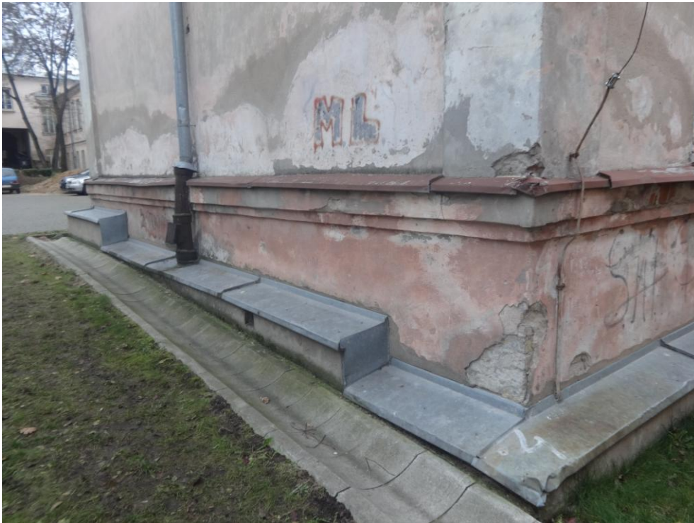
Fot.nr 24. zniszczone obróbki blacharskie powodują wnikanie wody w strukturę murów
