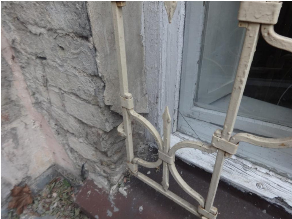
Fot.nr 29. zniszczone obróbki blacharskie powodują wnikanie wody w strukturę murów i dodatkowo powodują niszczenie stolarki okiennej
