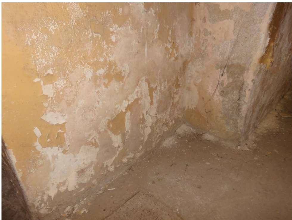
Fot.nr 26. brak właściwej izolacji prowadzi do zniszczenia struktury zawilgoconej ściany
