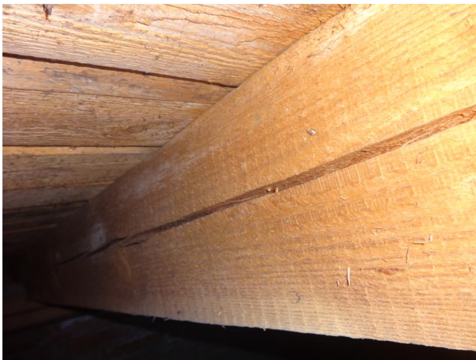
Fot.nr 38. widoczny element konstrukcyjny rozwarstwiony wraz z deskowaniem
