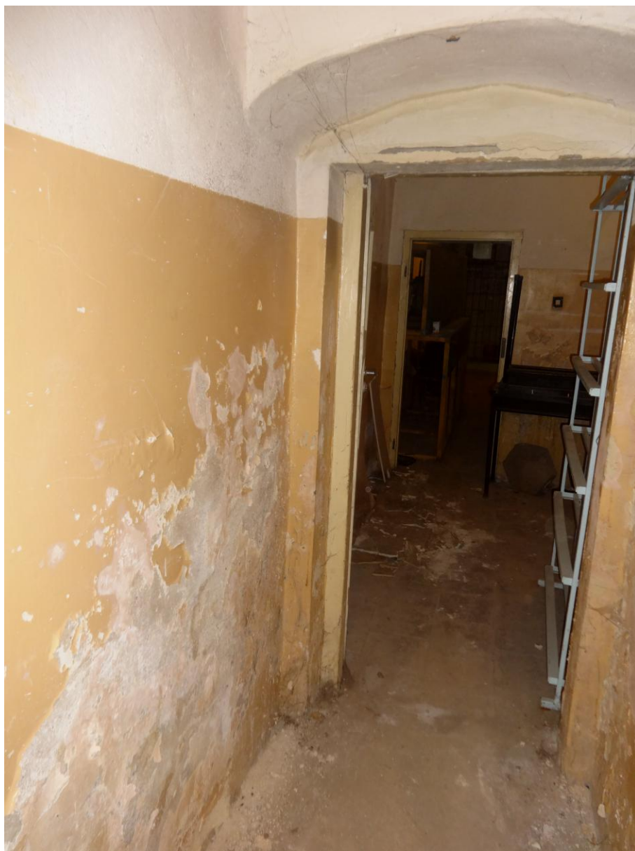
Fot.nr 27. brak właściwej izolacji prowadzi do zniszczenia struktury zawilgoconej ściany
