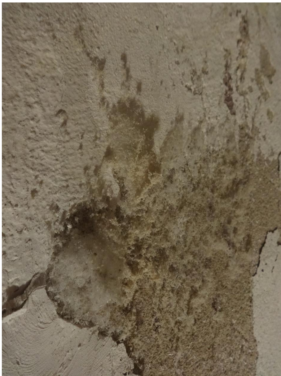
Fot.nr 31. widoczne wysolenia spowodowane kapilarnym podciąganiem wilgoci
