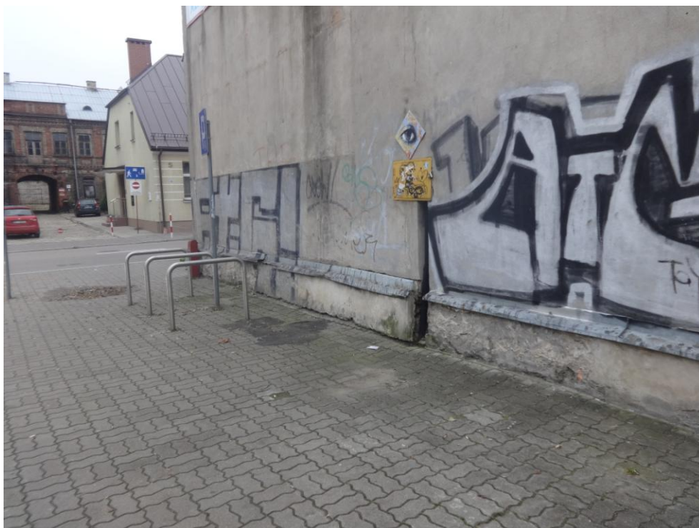
Fot.nr 3. zniszczona elewacja oraz substancja muru. Niewłaściwe ukształtowanie terenu wokół budynku powoduje dodatkowe zwilgocenie obiektu
