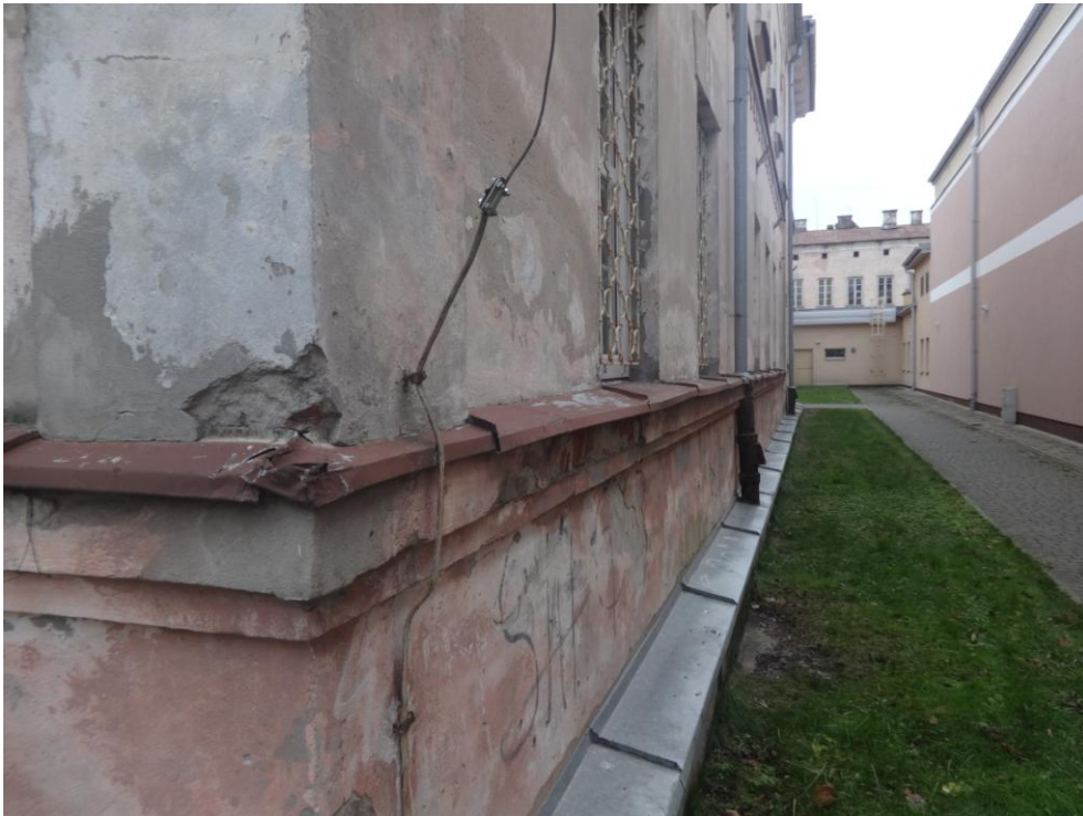
Fot.nr 22. zniszczona elewacja. Niewłaściwe ukształtowanie terenu wokół budynku powoduje dodatkowe zwilgocenie obiektu
