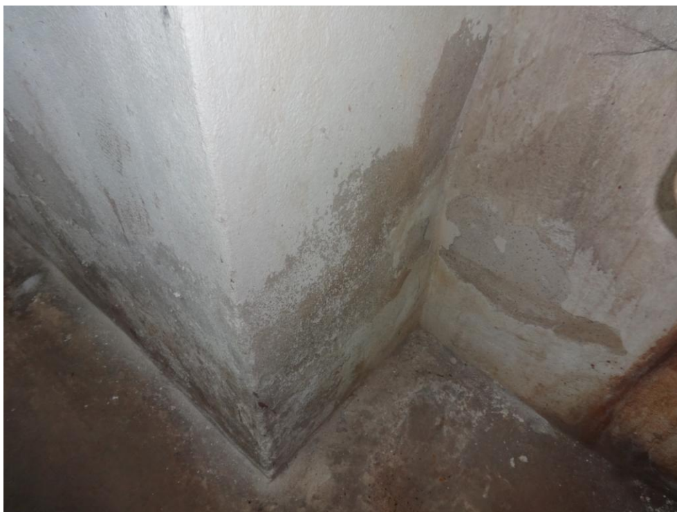
Fot.nr 35. widoczne zniszczenia spowodowane kapilarnym podciąganiem wilgoci
