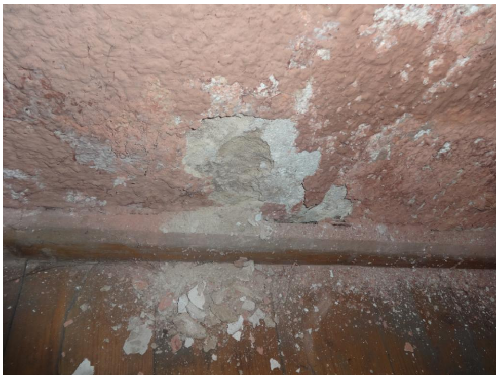
Fot.nr 23. widoczne zniszczenie spowodowane brakiem właściwej izolacji przeciwwilgociowej
