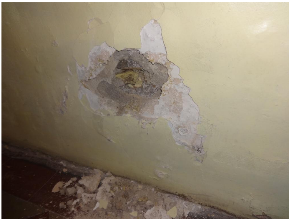
Fot.nr 50. widoczna odkrywka ukazująca strukturę ściany, widoczny jest brak izolacji przeciwwilgociowej
