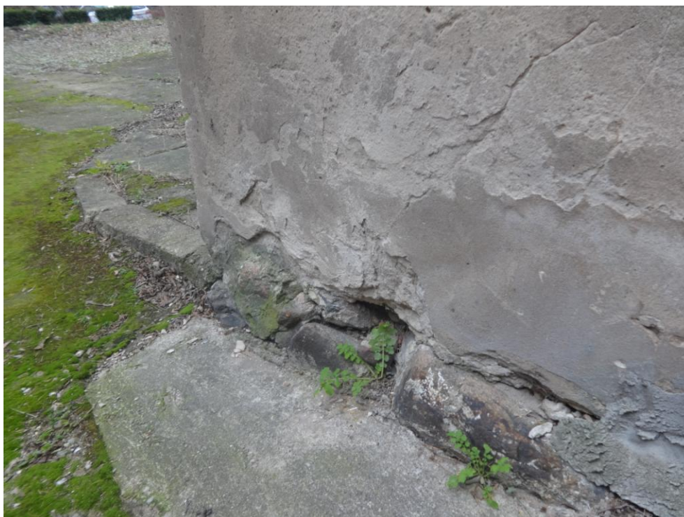
Fot.nr 13. zniszczona elewacja oraz substancja muru. Widoczny brak izolacji przeciwwilgociowej oraz kamienne elementy fundamentów
