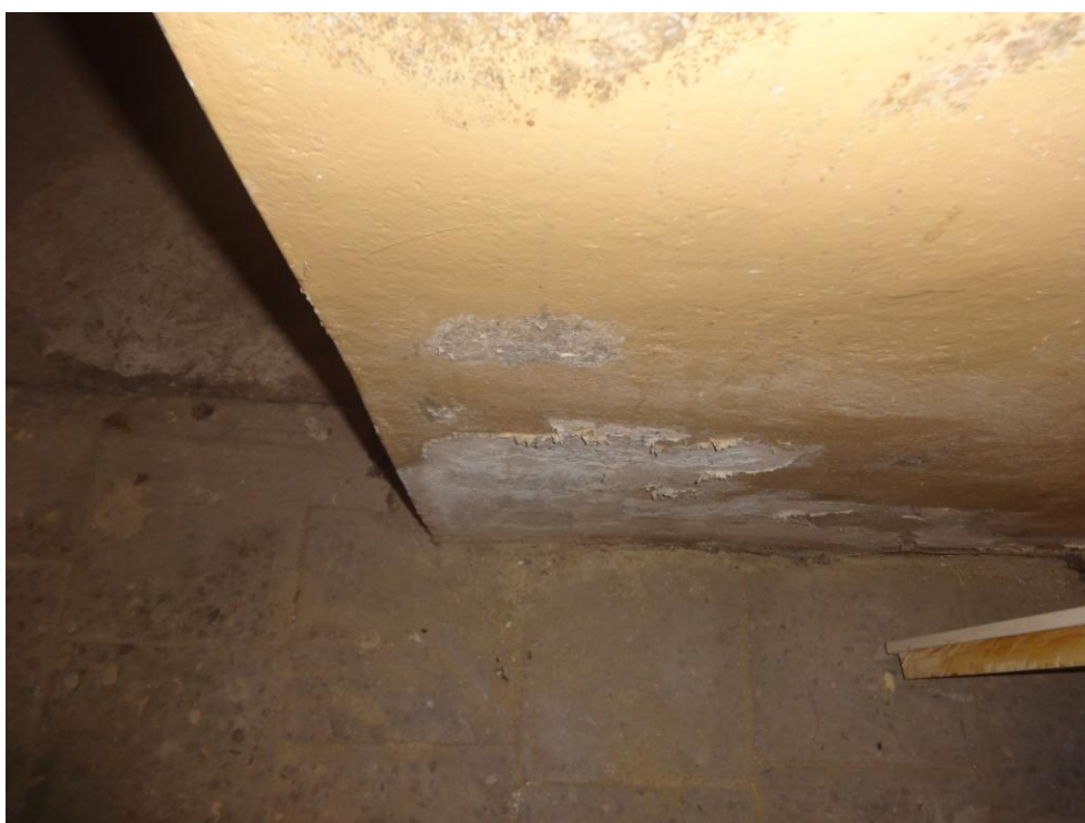
Fot.nr 24. zniszczona wyprawa malarska przez kapilarne podciąganie wilgoci
