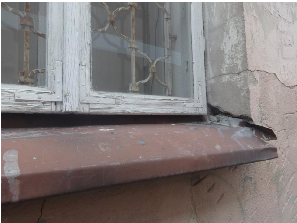
Fot.nr 30. zniszczone obróbki blacharskie powodują wnikanie wody w strukturę murów i dodatkowo powodują niszczenie stolarki okiennej
