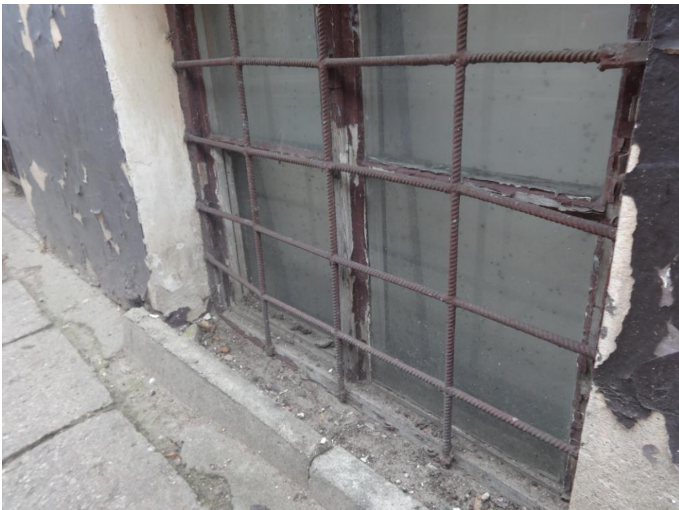
Fot.nr 8. zniszczona elewacja oraz stolarka okienna
