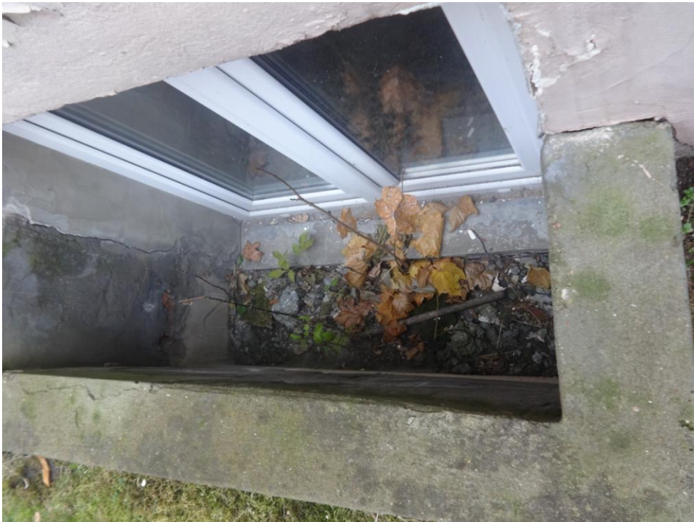
Fot.nr 20. brak właściwego odprowadzenia wody powoduje dodatkowe zawilgocenie obiektu
