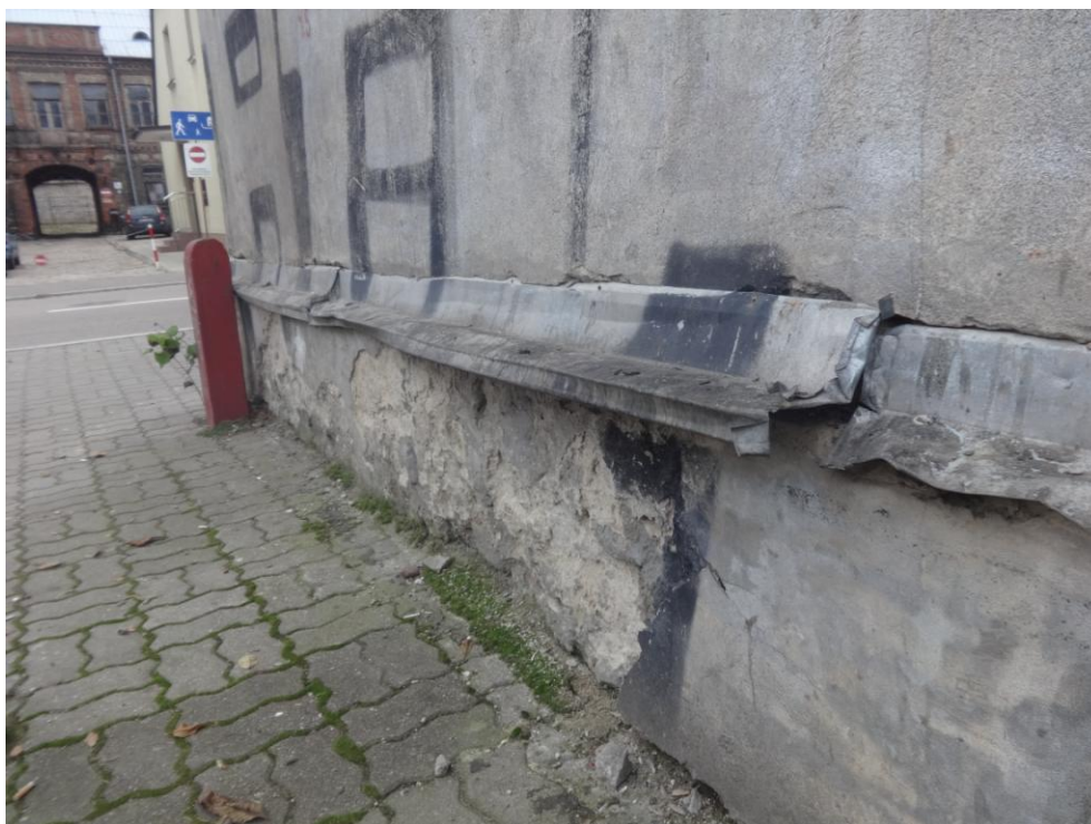
Fot.nr 4. zniszczona elewacja oraz substancja muru. Niewłaściwe ukształtowanie terenu wokół budynku powoduje dodatkowe zwilgocenie obiektu
