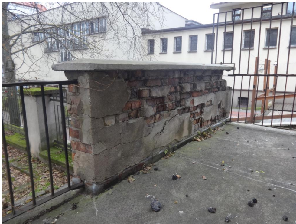
Fot.nr 19. widoczne zniszczenie spowodowane brakiem właściwej izolacji przeciwwilgociowej
