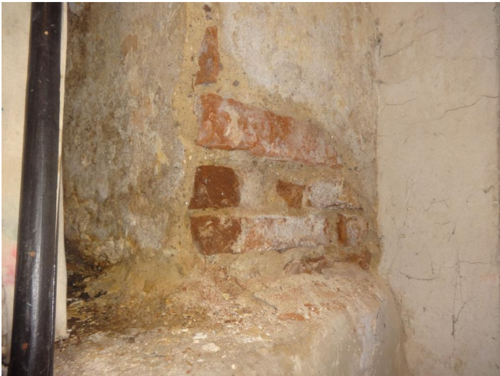
Fot.nr 46. zniszczenia ściany spowodowane brakiem izolacji przeciwwilgociowej
