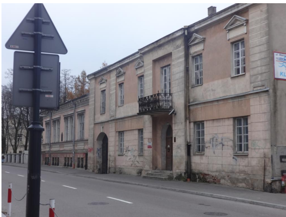
Fot.nr 2. widok budynku głównego objętego opracowaniem, widoczne silne zawilgocenie murów
