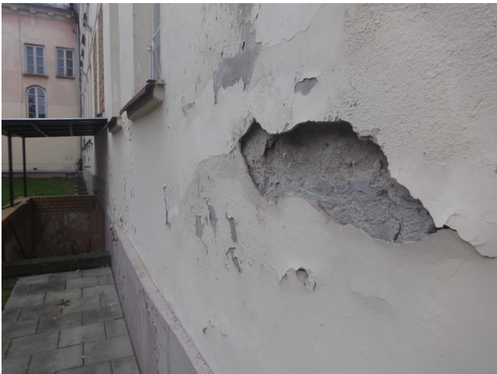
Fot.nr 17. zniszczona elewacja. Silne zawilgocenie murów powoduje niszczenie i odspajanie wypraw tynkarskich
