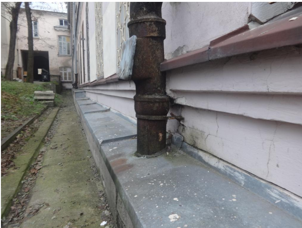
Fot.nr 32. zniszczone obróbki blacharskie powodują wnikanie wody w strukturę murów i dodatkowo powodują tynków
