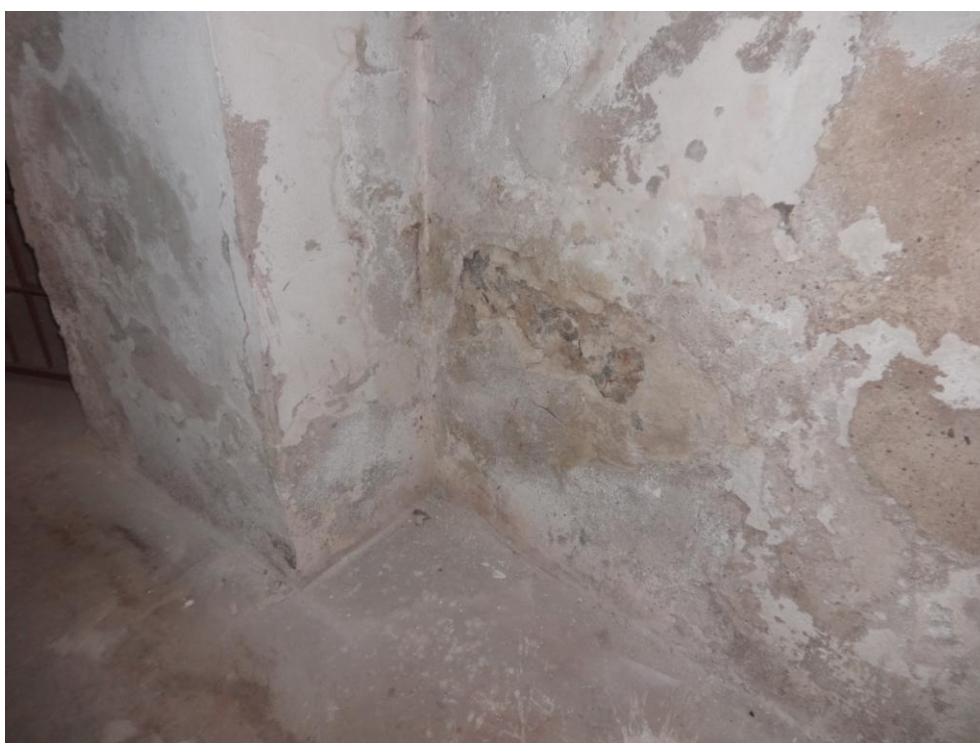
Fot.nr 30. widoczne zniszczenia spowodowane kapilarnym podciąganiem wilgoci
