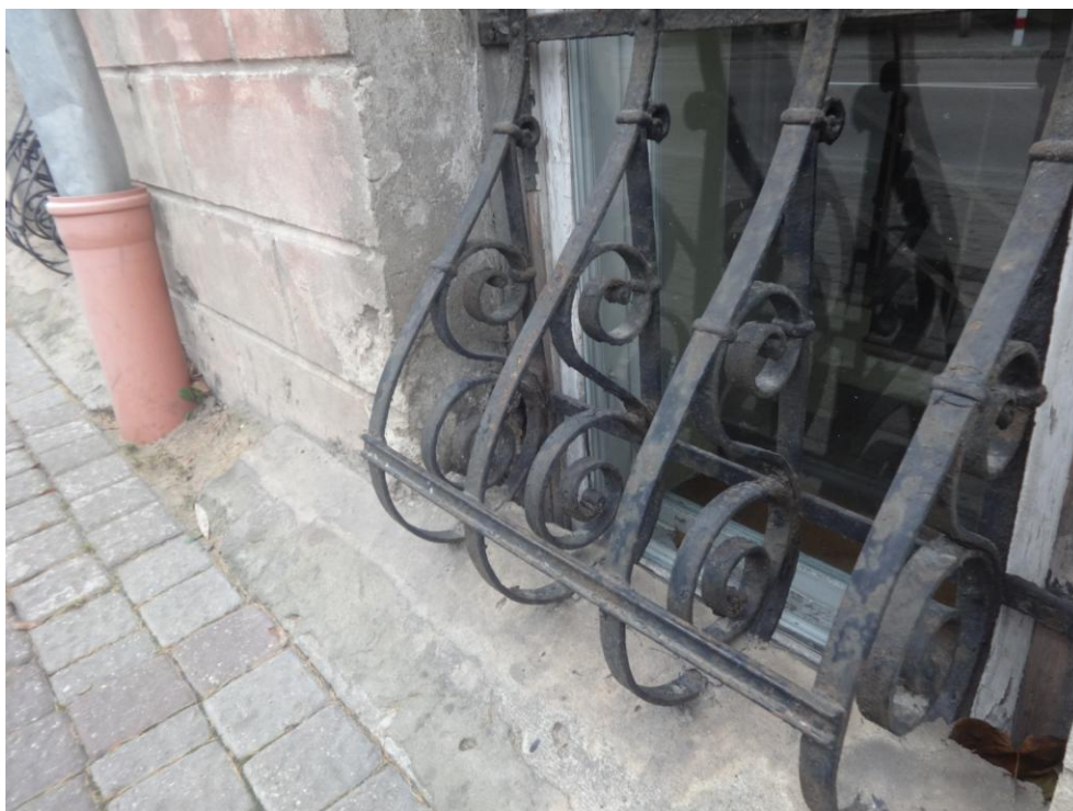
Fot.nr 10. zniszczona elewacja oraz substancja muru. Widoczne zagłębienie okien poniżej poziomu terenu
