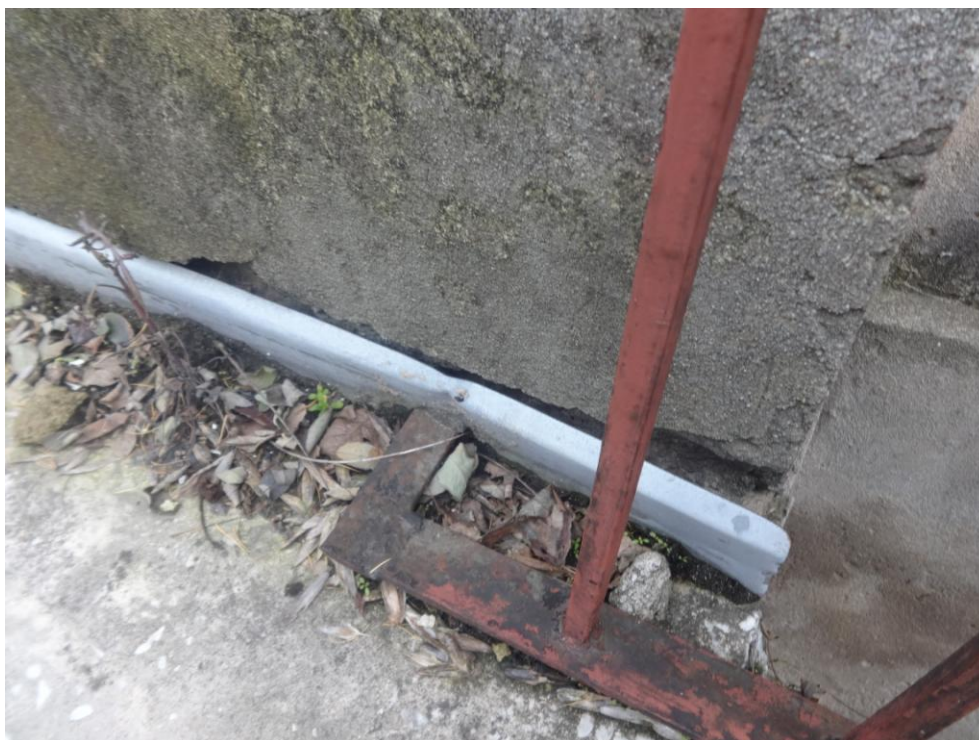
Fot.nr 16. zniszczona obróbki blacharskie dodatkowo przyczyniają się do zawilgocenia budynku
