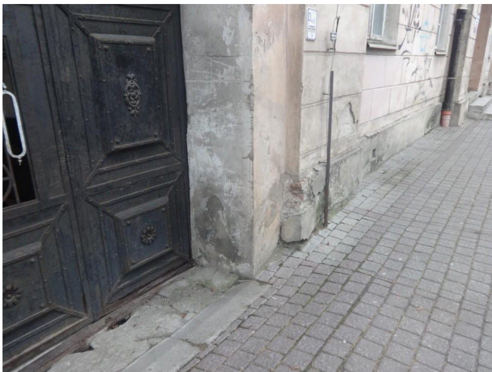
Fot.nr 9. zniszczona elewacja oraz substancja muru. Niewłaściwe ukształtowanie terenu wokół budynku powoduje dodatkowe zwilgocenie obiektu
