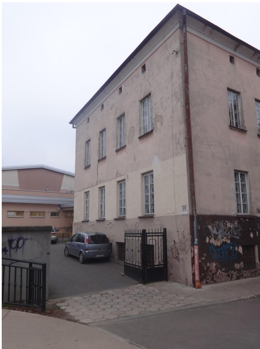
Fot.nr 12. zniszczona elewacja. Niewłaściwe ukształtowanie terenu wokół budynku powoduje dodatkowe zwilgocenie obiektu
