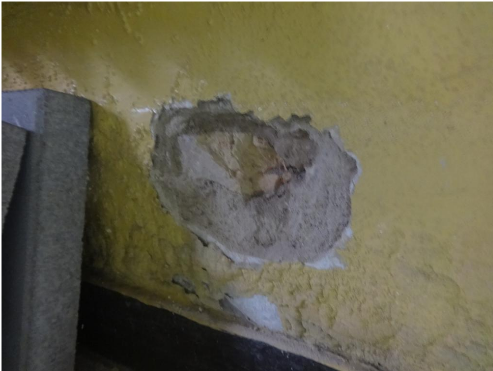
Fot.nr 43. widoczna odkrywka mająca na celu pobranie próbek materiału ściany do badań laboratoryjnych
