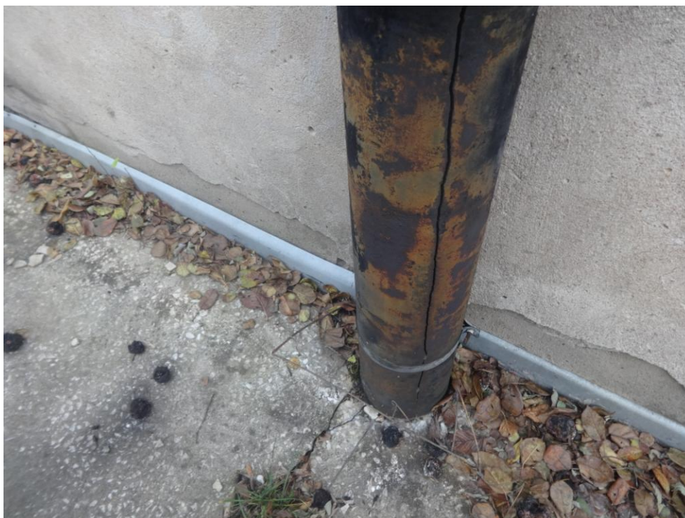
Fot.nr 17. zniszczona obróbki blacharskie dodatkowo przyczyniają się do zawilgocenia budynku
