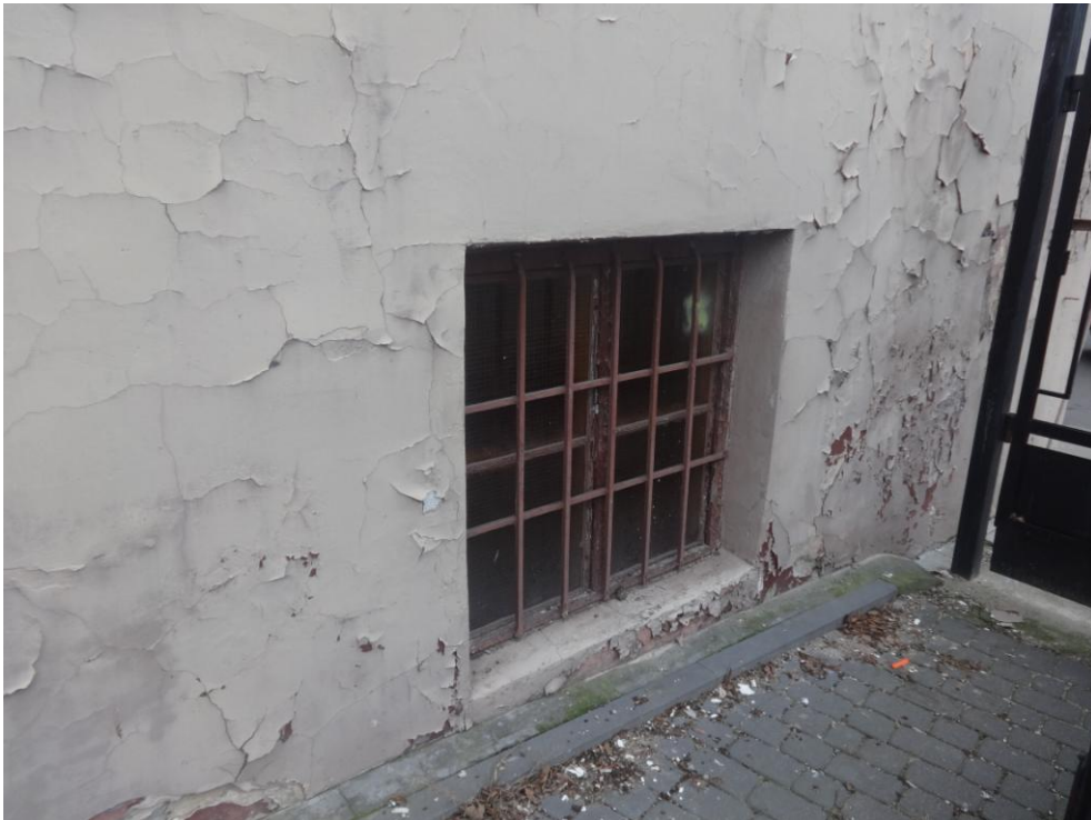
Fot.nr 14. widoczne zniszczenia elewacji spowodowane silnym zawilgoceniem budynku
