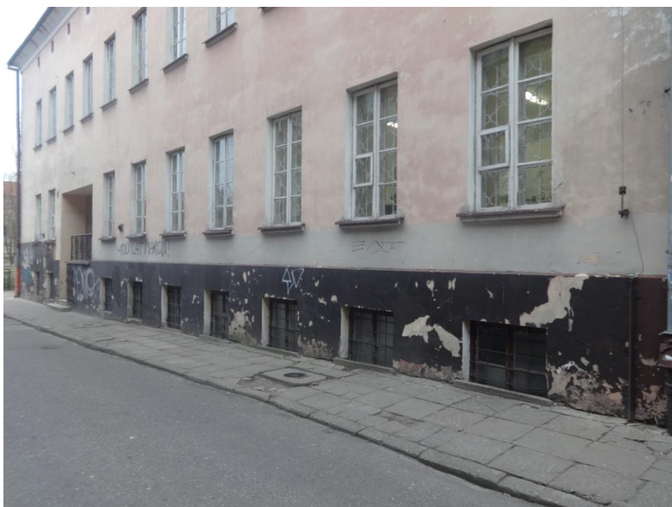
Fot. nr 4. widok budynku głównego objętego opracowaniem. Zniszczona elewacja budynku spowodowana brakiem właściwej izolacji
