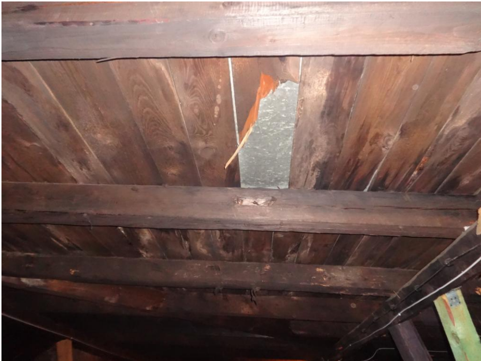
Fot.nr 58. widoczna konstrukcja wieżby dachowej wraz z pokryciem z blachy ocynkowanej. Widoczne zniszczone deskowanie dachu
