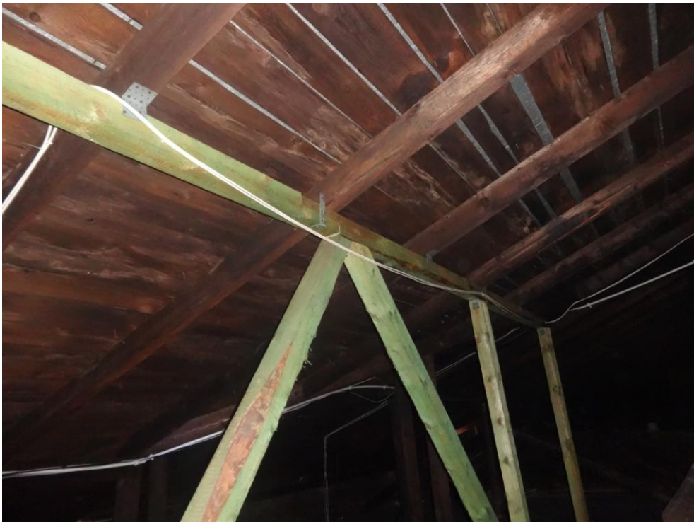
Fot.nr 57. widoczna konstrukcja więźby dachowej wraz z pokryciem z blachy ocynkowanej oraz nowymi elementami konstrukcji
