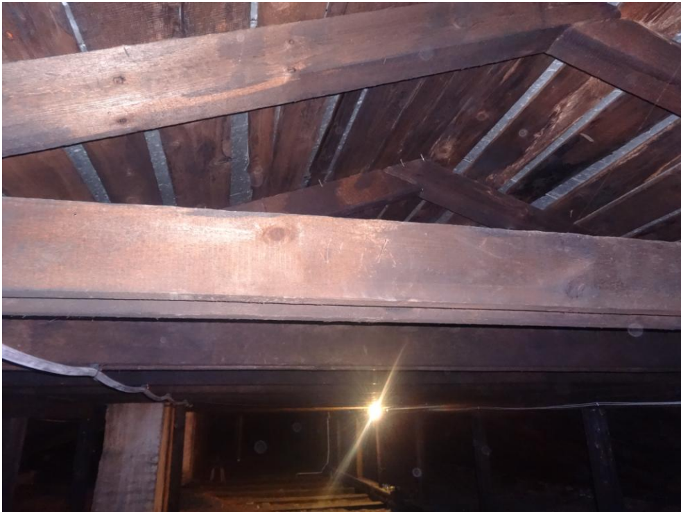
Fot.nr 60. konstrukcja więźby dachowej wraz z widocznym deskowaniem dachu
