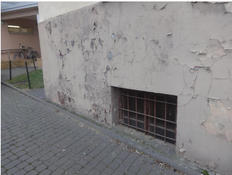
Fot.nr 15. brak właściwej izolacji powoduje niszczenie substancji muru
