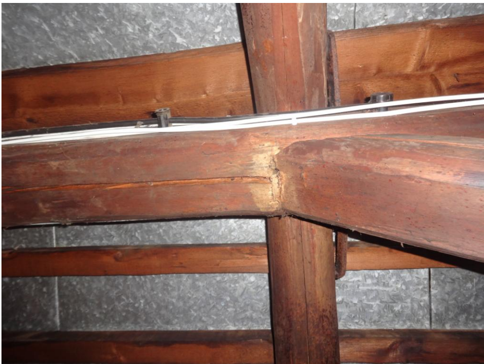
Fot.nr 53. widoczna konstrukcja wieżby dachowej wraz z pokryciem z blachy ocynkowanej. Widoczne spękania konstrukcji
