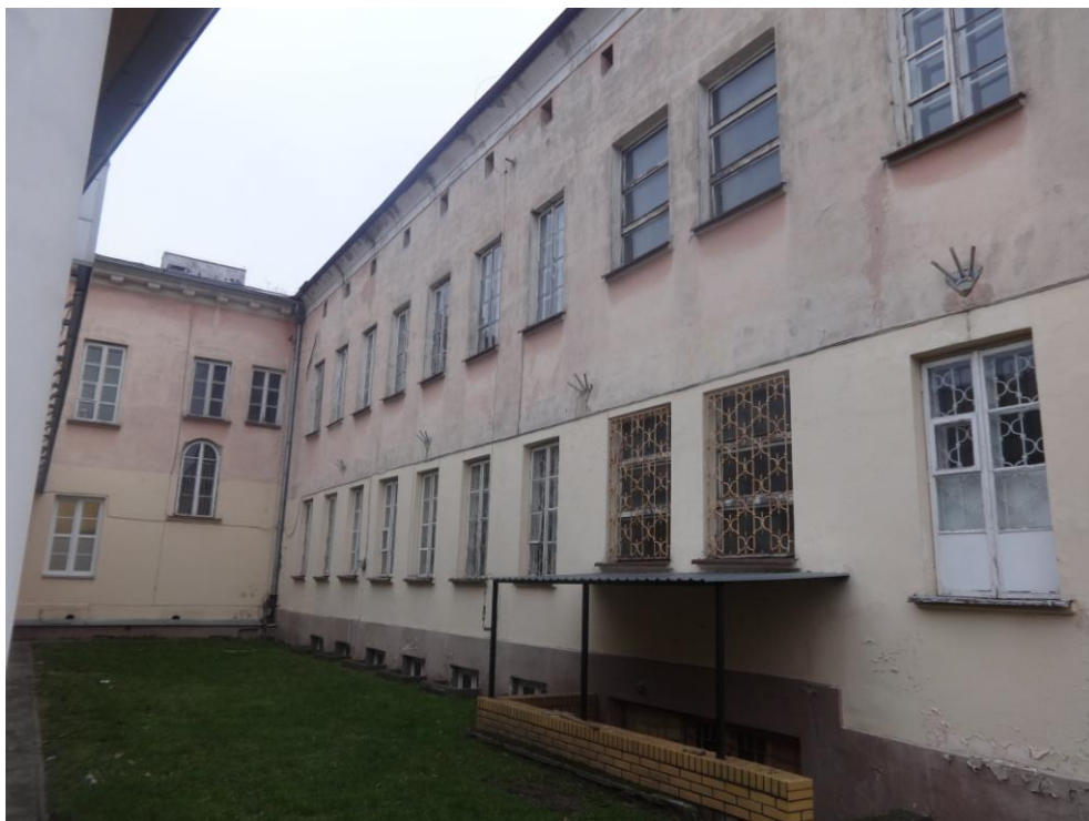
Fot.nr 18. zniszczona elewacja.wraz z wyprawami tynkarskimi
