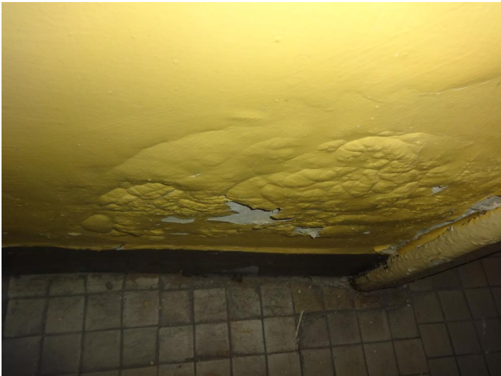
Fot.nr 38. widoczne zniszczenia spowodowane silnym zawilgoceniem murów
