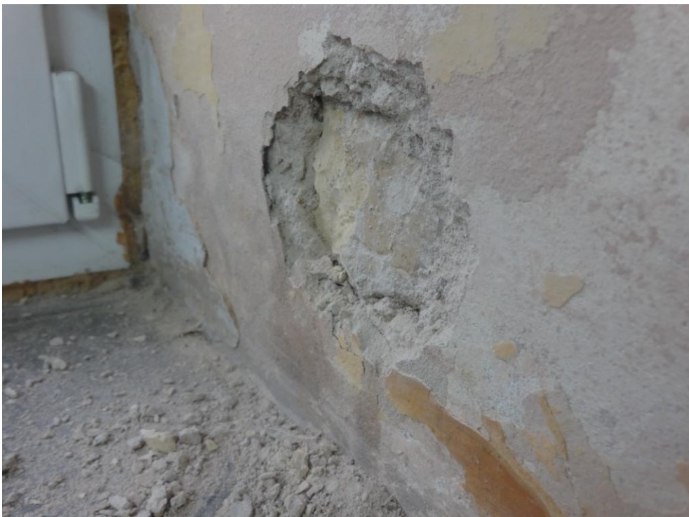
Fot.nr 44. widoczna odkrywka mająca na celu pobranie próbek materiału ściany do badań laboratoryjnych
