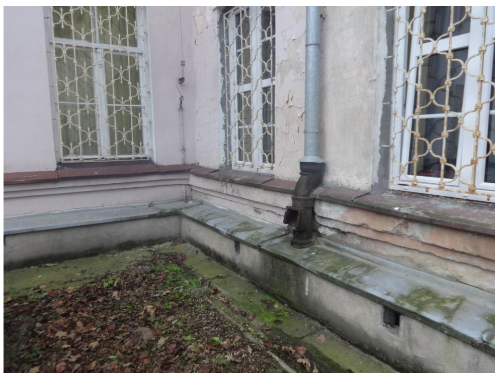
Fot.nr 27. zniszczone obróbki blacharskie powodują wnikanie wody w strukturę murów
