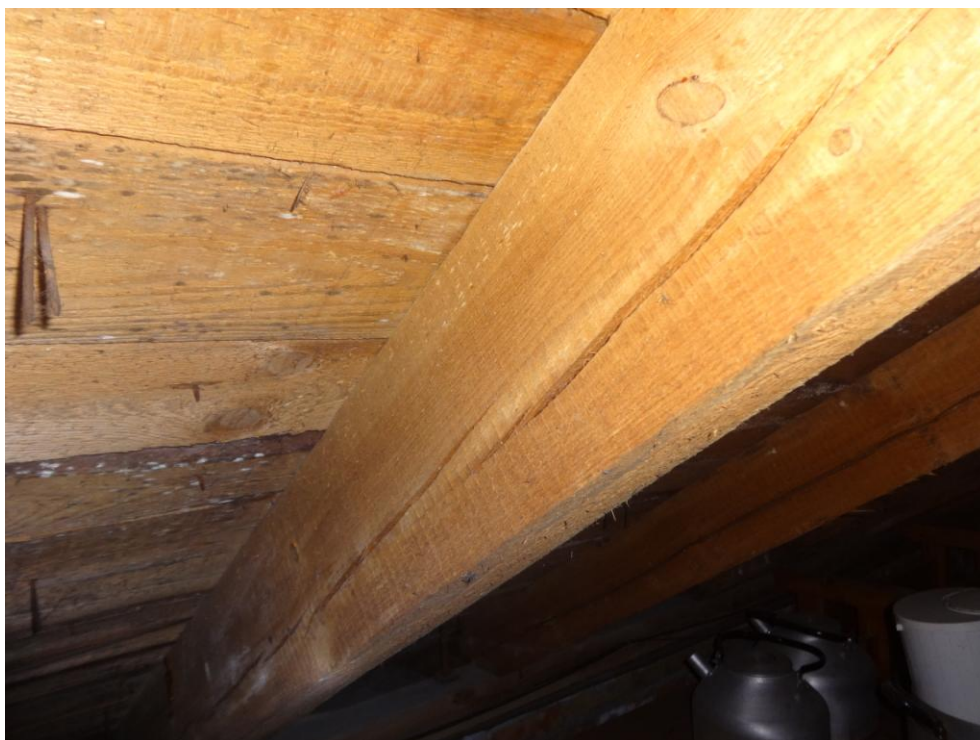
Fot.nr 36. widoczna konstrukcja wieżby dachowej wraz z deskowaniem. Widoczne spękania konstrukcji
