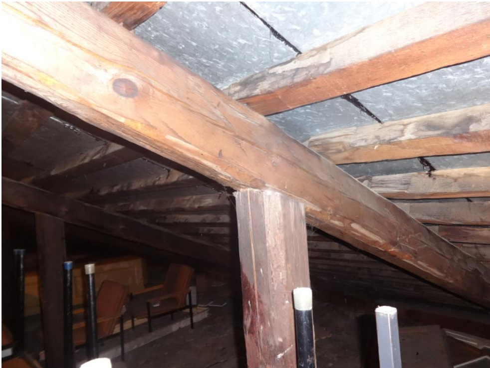
Fot.nr 54. widoczna konstrukcja wieżby dachowej wraz z pokryciem z blachy ocynkowanej. Widoczne elementy konstrukcji dachowej
