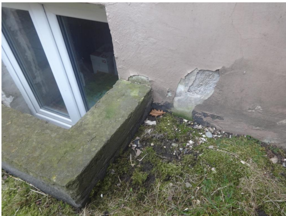
Fot.nr 19. zniszczona elewacja.Brak właściwej izolacji powoduje niszczenie tynków i murów
