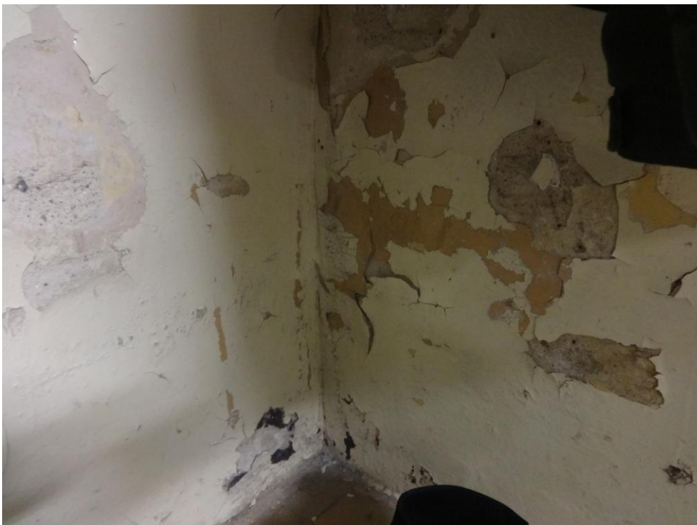
Fot.nr 48. zniszczenia ściany spowodowane brakiem izolacji przeciwwilgociowej
