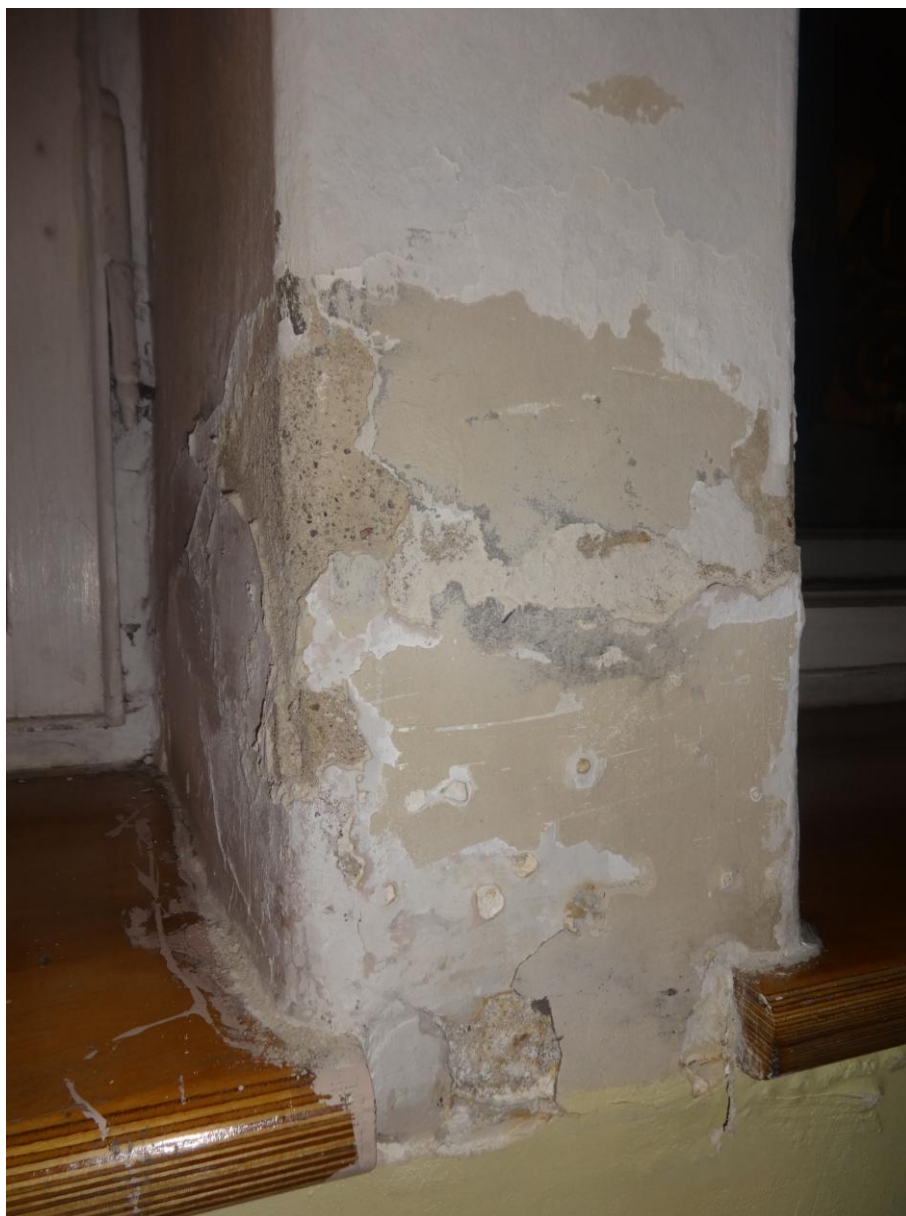
Fot.nr 51. zniszczenia ściany spowodowane brakiem izolacji przeciwwilgociowej
