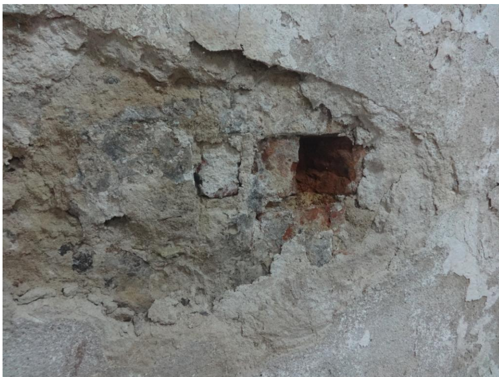
Fot.nr 32. widoczne odkrywki mające ustalić strukturę zawilgoconej ściany
