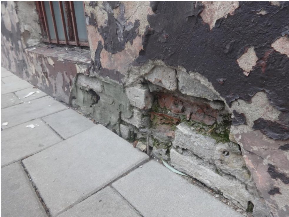
Fot.nr 7. zniszczona elewacja oraz substancja muru. Niewłaściwe ukształtowanie terenu wokół budynku powoduje dodatkowe zwilgocenie obiektu
