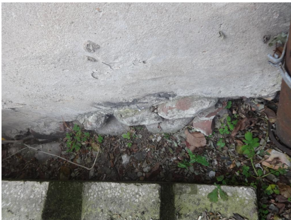
Fot.nr 15. zniszczona elewacja oraz substancja muru. Niewłaściwe ukształtowanie terenu wokół budynku powoduje dodatkowe zwilgocenie obiektu
