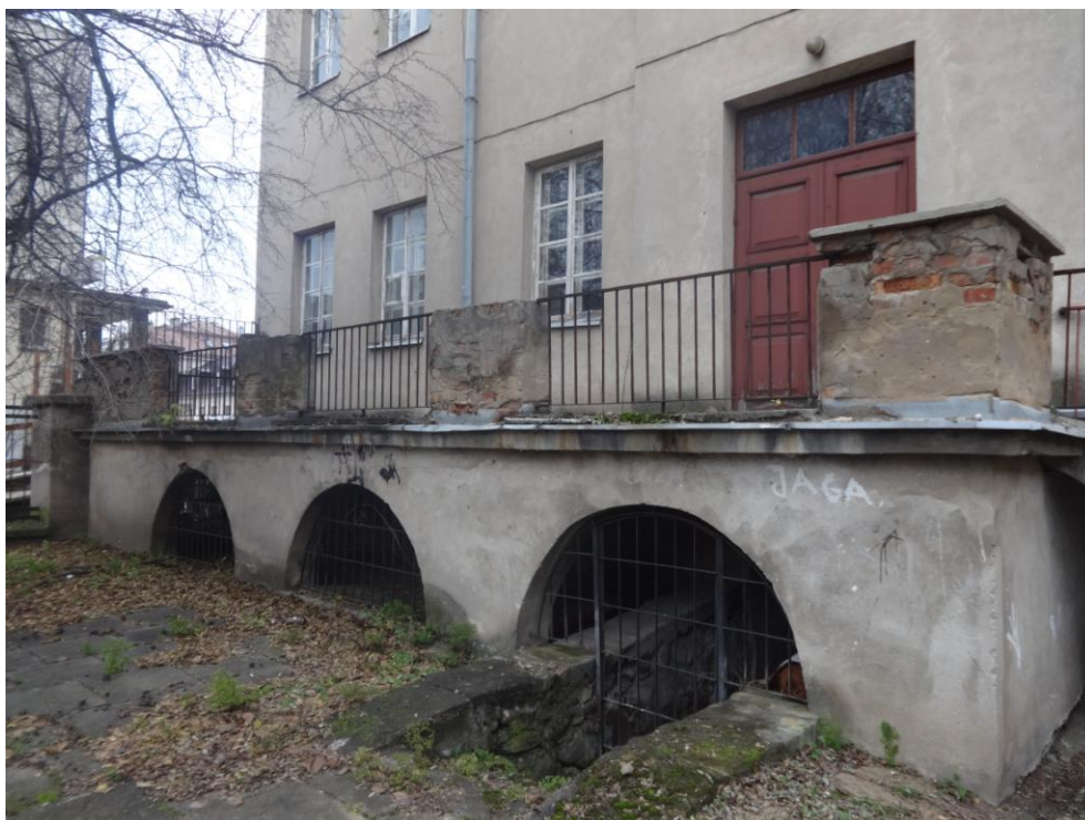
Fot.nr 21. widoczne zniszczenie spowodowane brakiem właściwej izolacji przeciwwilgociowej
