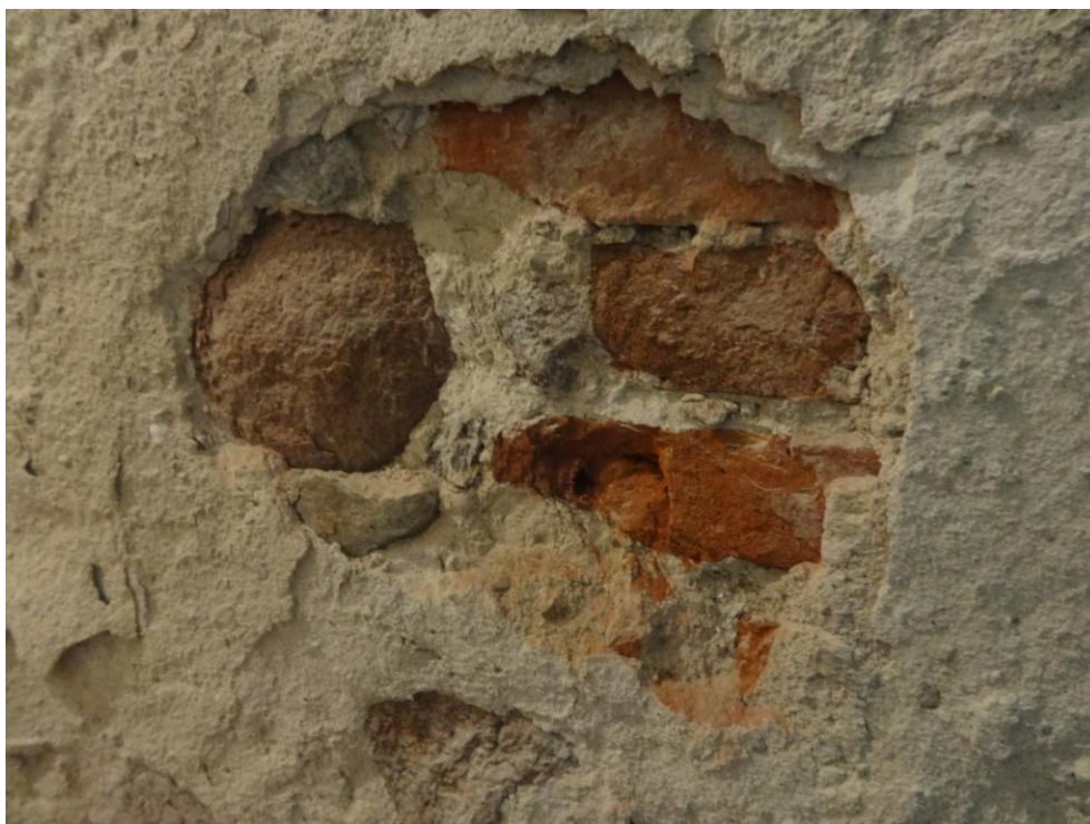
Fot.nr 34. widoczne odkrywki mające ustalić strukturę zawilgoconej ściany. Widoczne połączenie cegły i kamieni
