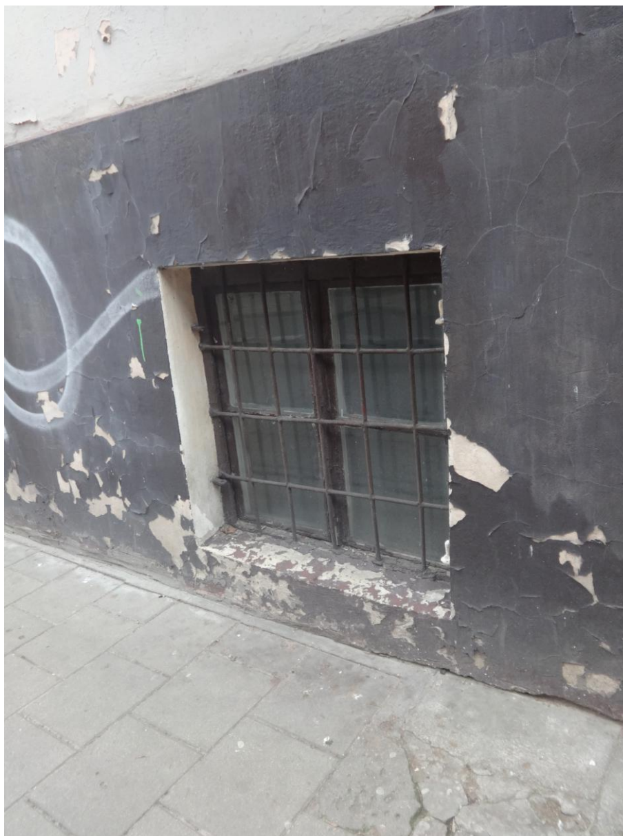
Fot.nr 9. zniszczona elewacja oraz substancja muru. Niewłaściwe ukształtowanie terenu wokół budynku powoduje dodatkowe zwilgocenie obiektu
