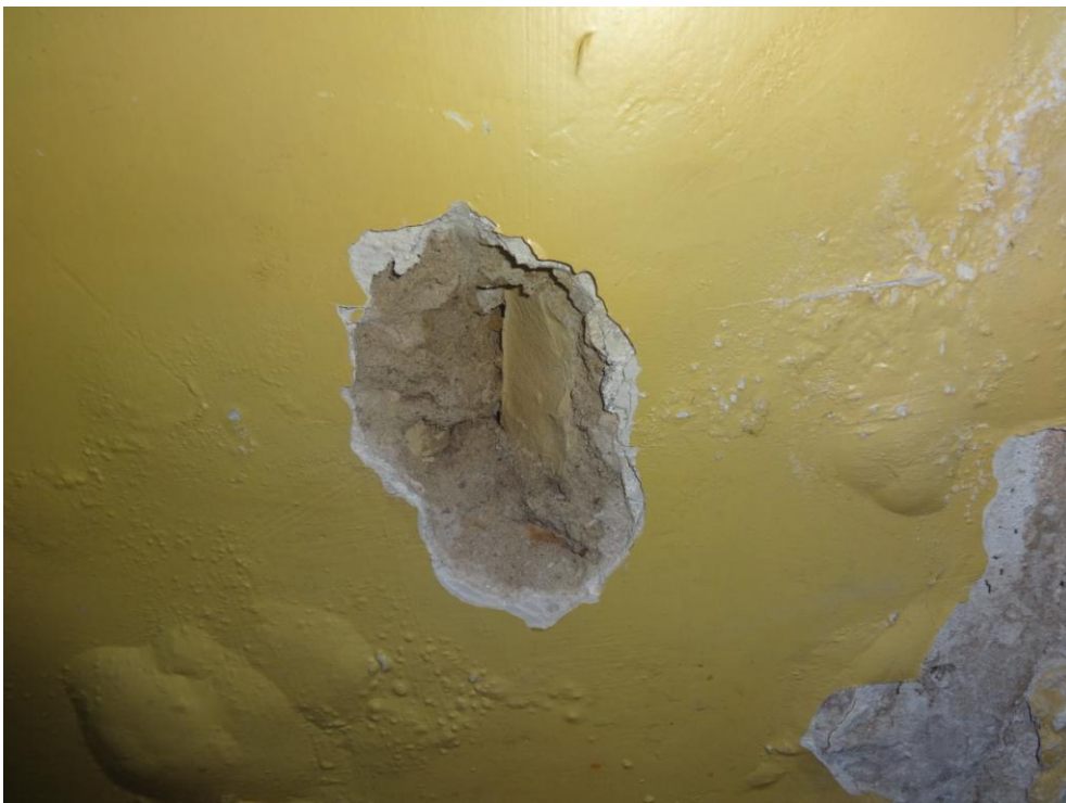
Fot.nr 42. widoczna odkrywka mająca na celu pobranie próbek materiału ściany do badań laboratoryjnych
