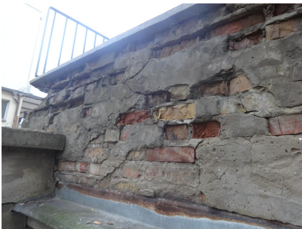
Fot.nr 22. widoczne zniszczenie spowodowane brakiem właściwej izolacji przeciwwilgociowej
