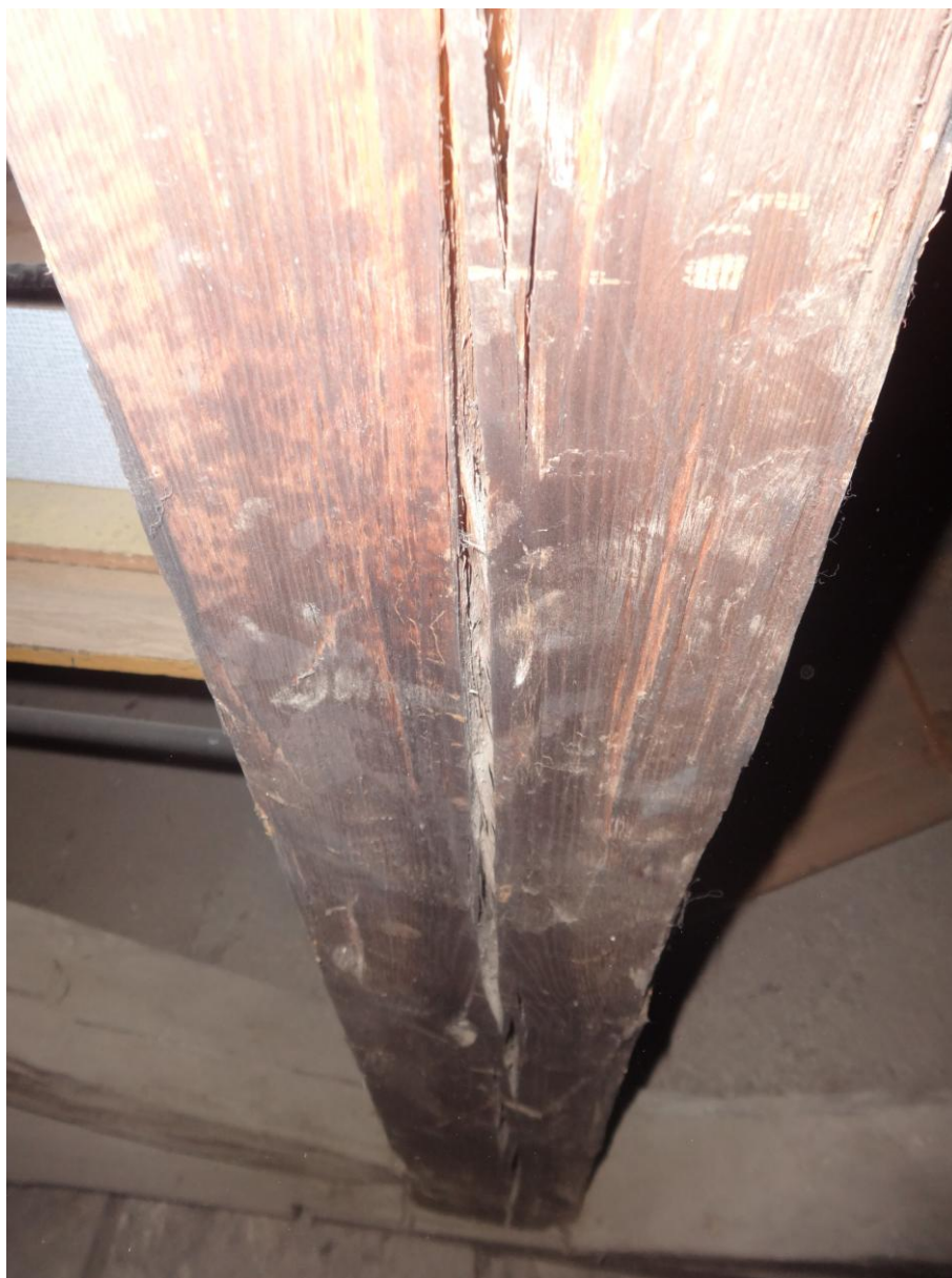
Fot.nr 61. widoczny element konstrukcji zniszczony przez rozwarstwienie i spękania
