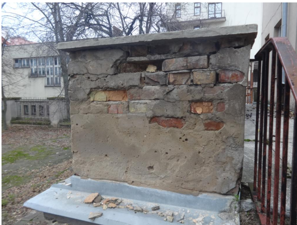
Fot.nr 18. zniszczona obróbki blacharskie dodatkowo przyczyniają się do zawilgocenia budynku. Widoczne zniszczenie substancji muru
