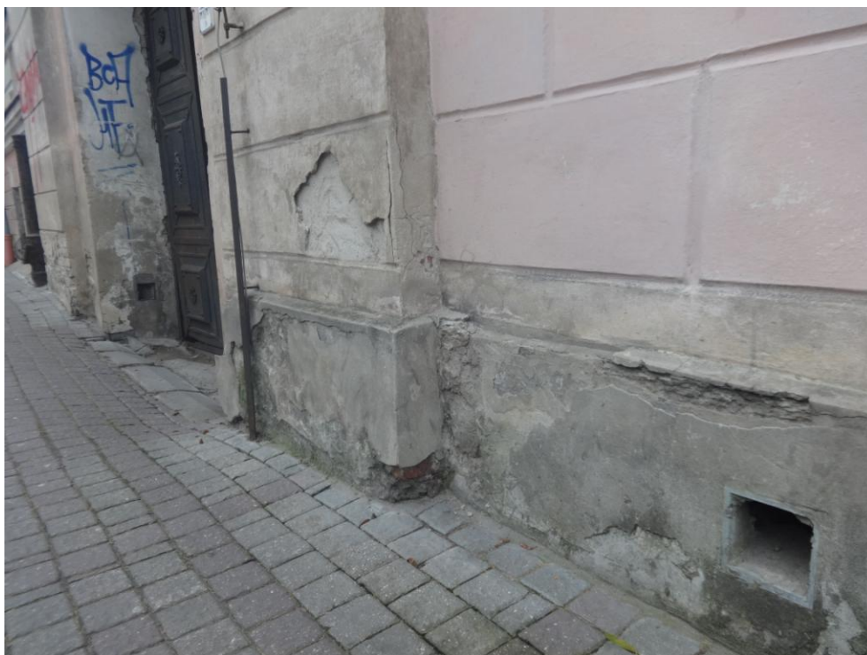
Fot.nr 7. zniszczona elewacja oraz substancja muru. Widoczne liczne przebarwienia tynku i odpajanie warstwy z wymalowaniem
