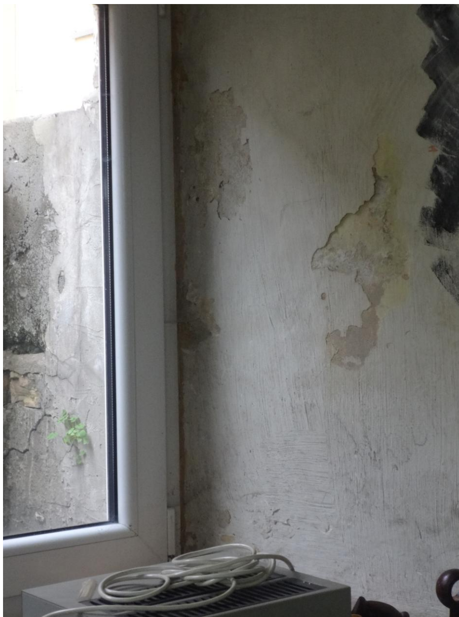
Fot.nr 40. widoczne zniszczenia spowodowane silnym zawilgoceniem murów
