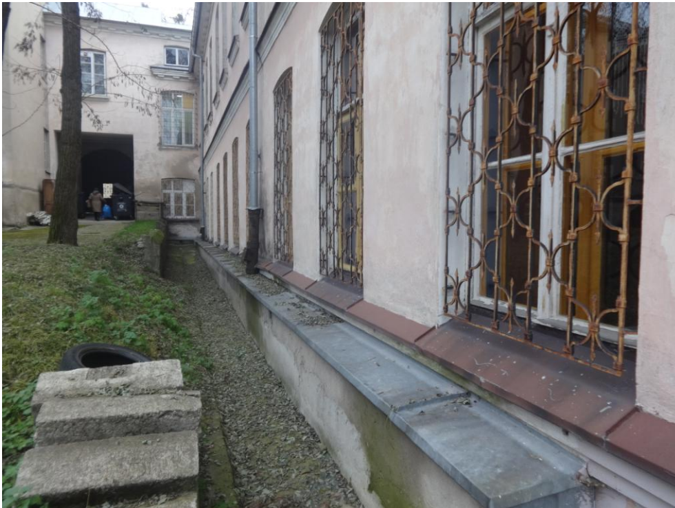
Fot.nr 31. zniszczone obróbki blacharskie powodują wnikanie wody w strukturę murów i dodatkowo powodują niszczenie stolarki okiennej
