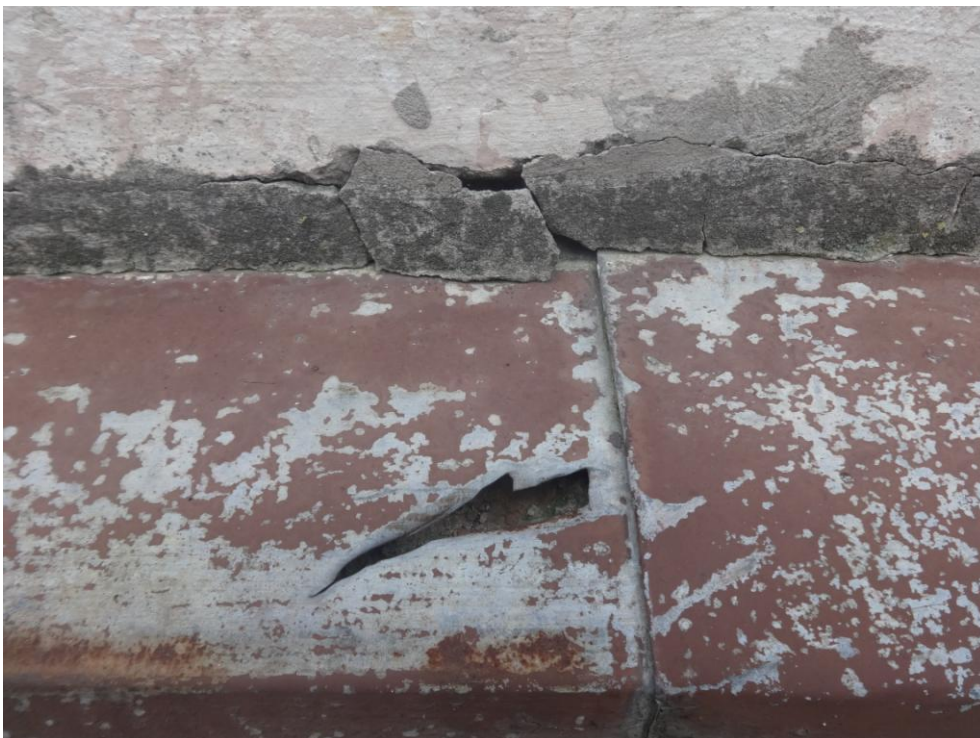
Fot.nr 23. zniszczone obróbki blacharskie powodują wnikanie wody w strukturę murów
