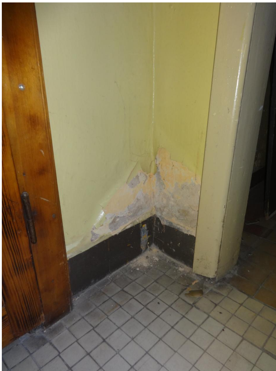
Fot.nr 39. widoczne zniszczenia spowodowane podciąganiem kapilarnym wody
