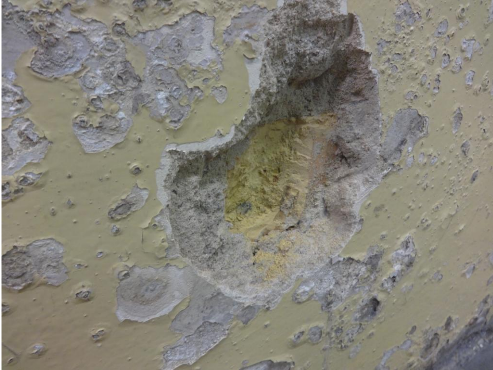
Fot.nr 45. zniszczenia ściany spowodowane brakiem izolacji przeciwwilgociowej
