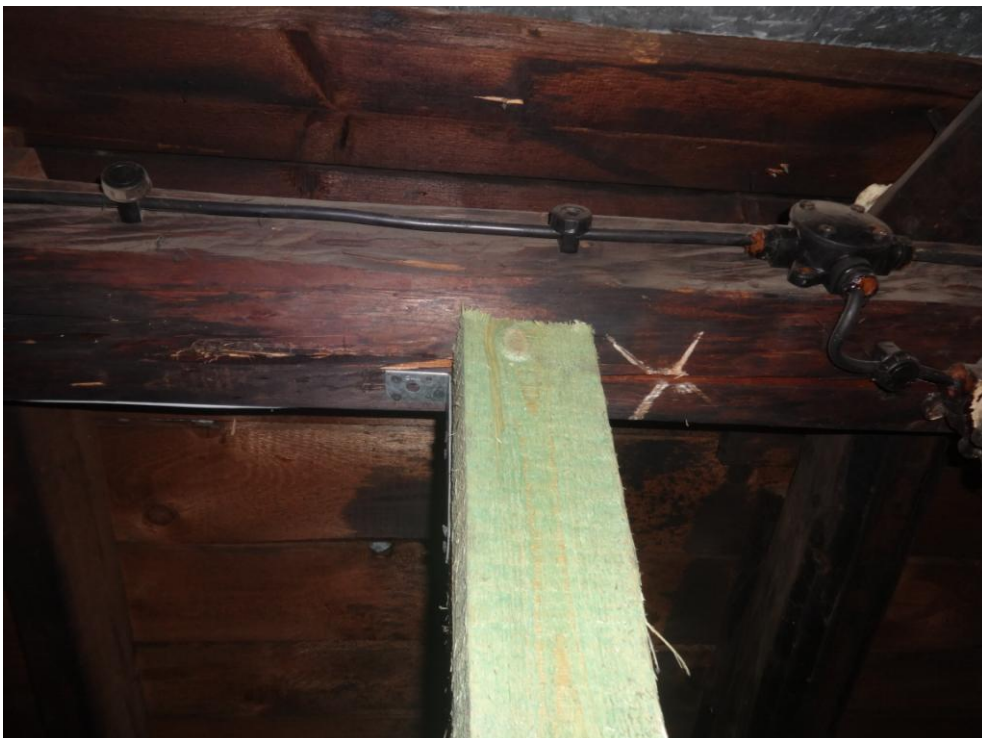
Fot.nr 55. widoczna konstrukcja wieżby dachowej wraz z nowym elementem konstrukcji więźby dachowej
