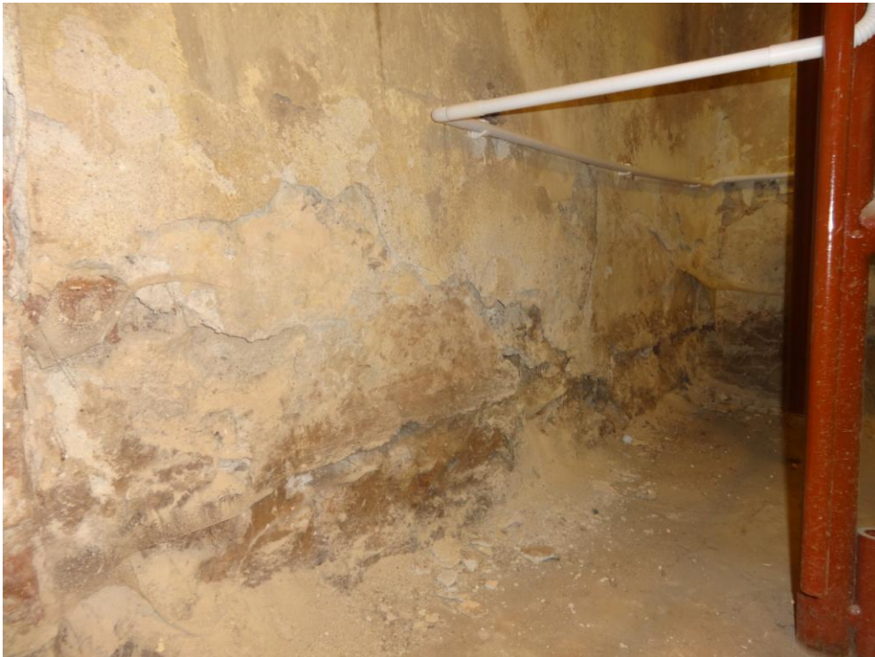
Fot.nr 47. zniszczenia ściany spowodowane brakiem izolacji przeciwwilgociowej
