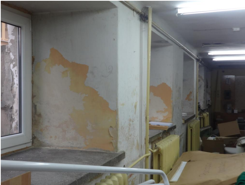
Fot.nr 35. widoczne zniszczenia spowodowane silnym zawilgoceniem murów
