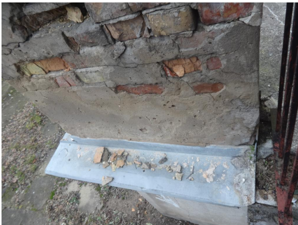
Fot.nr 20. widoczne zniszczenie spowodowane brakiem właściwej izolacji przeciwwilgociowej
