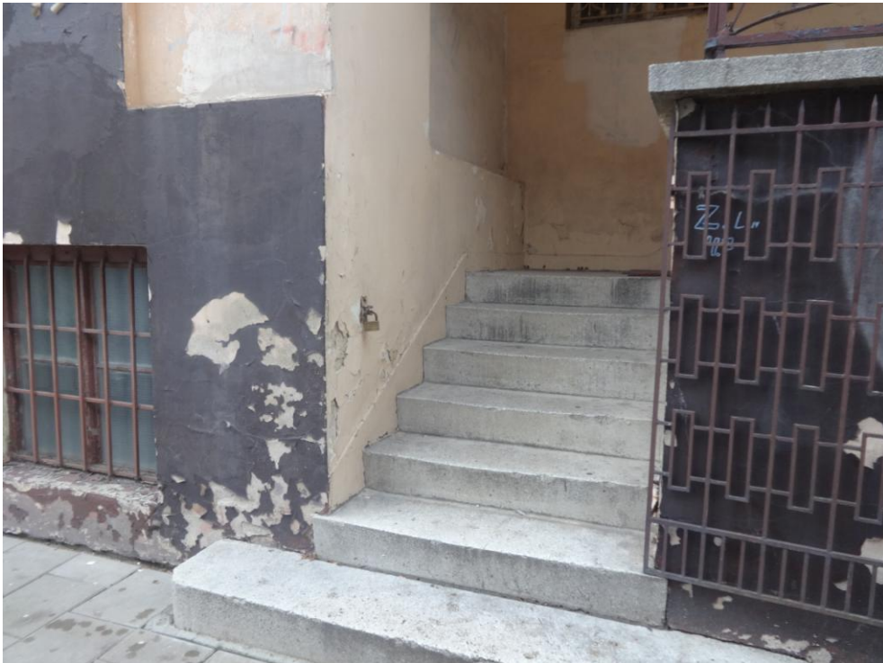
Fot.nr 10. zniszczona elewacja oraz substancja muru. Niewłaściwe ukształtowanie terenu wokół budynku powoduje dodatkowe zwilgocenie obiektu
