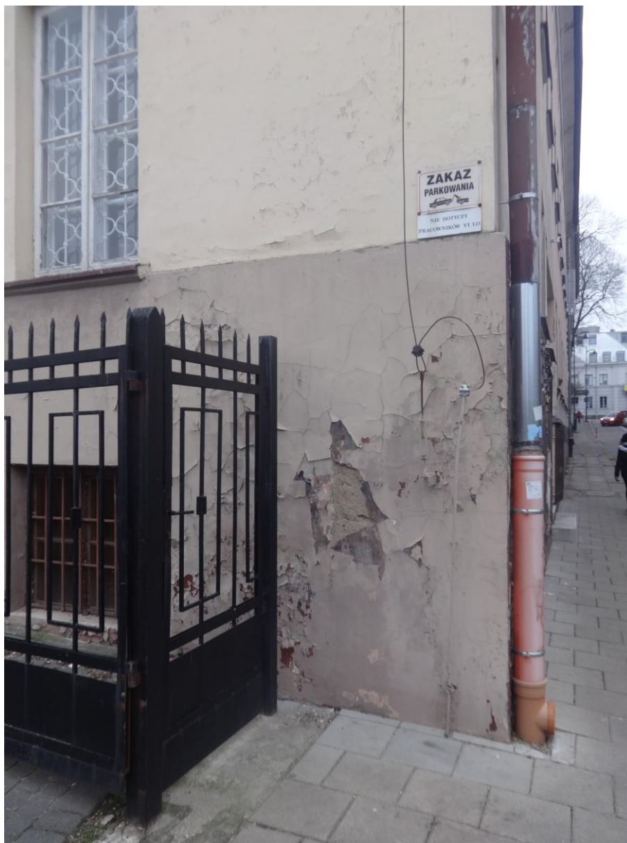
Fot.nr 13. zniszczona elewacja. Niewłaściwe ukształtowanie terenu wokół budynku powoduje dodatkowe zwilgocenie obiektu
