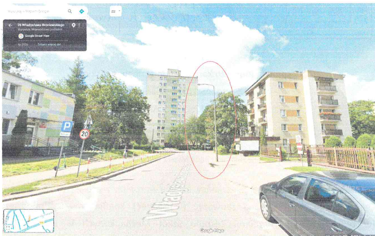
Fot. 1. Słup oświetlenia ulicznego do zamontowania kamery – widok od strony ulicy Antoniukowskiej
