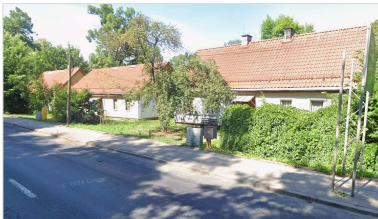
Zdjęcie 8 Fragment widoku na zespół domów z zabudową gospodarczą w osadzie przy fabryce Hasbacha przy ulicy ks. S. Suchowolca
