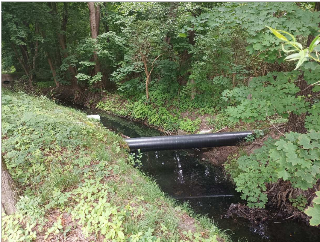
Zdjęcie 1 Ciek spod Dojlid Górnych od strony ul. ks. S. Suchowolca Fot. Elżbieta Drożdżał, 18.07.2025 r.
