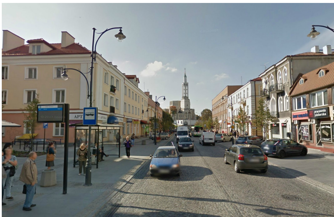
Rysunek 3–14. Białystok ul. Lipowa– przykład uspokojenia ruchu poprzez zmianę geometrii ulicy.
